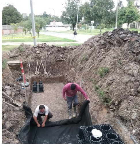
Fotografía 2-7: Colocación del geotextil NT2500.
