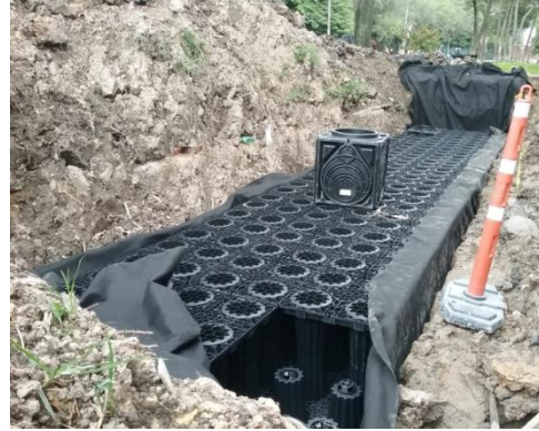
Fotografía 2-9 y Fotografía 2-10: Colocación de los elementos celulares.
