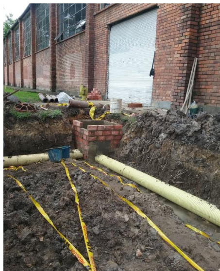
Fotografía 2-8: Conexión de la caja de inspección nueva con colector Ø8".
