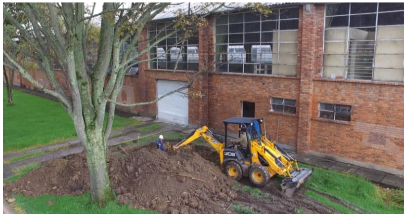
Fotografía 2-6: Inicio de instalación del tanque en el costado nororiental del Laboratorio de Ensayos Hidráulicos.
