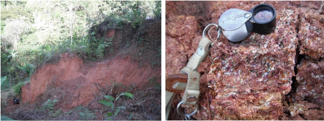
Fotografía 5-16. Suelo residual de dioritas.
