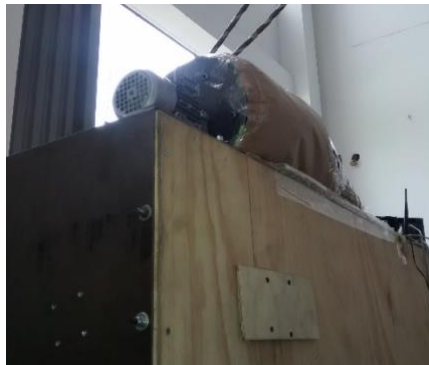
Figura 3-7: Instalación del motor centrífugo
