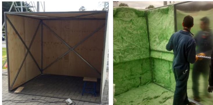
Figura 3-5: Soporte estructural de la cámara de envejecimiento
