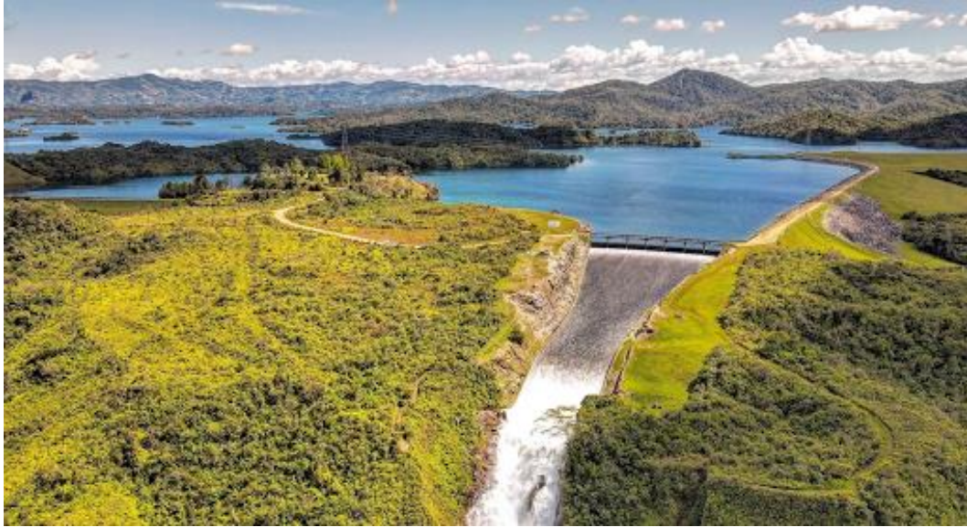
Fotografía 7-7 – Central hidroeléctrica Guatapé. Fuente: Informativo digital Heraldo del Norte
