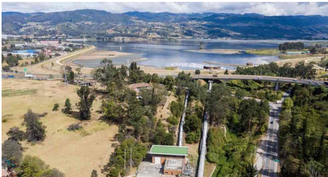
Fotografía 7-6 – Central hidroeléctrica Pagua, Embalse Muña. Fuente: Semana.com
