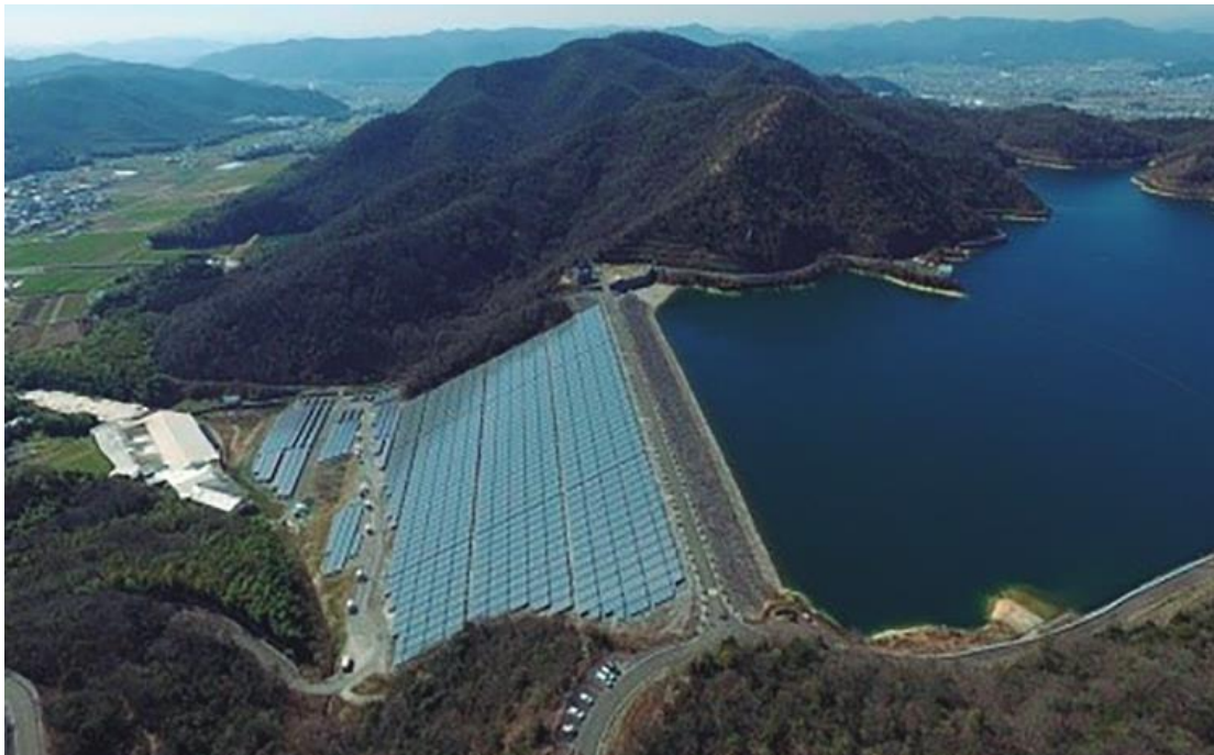
Fotografía 5-3 - Presa Heiso en Japón con paneles solares instalados
