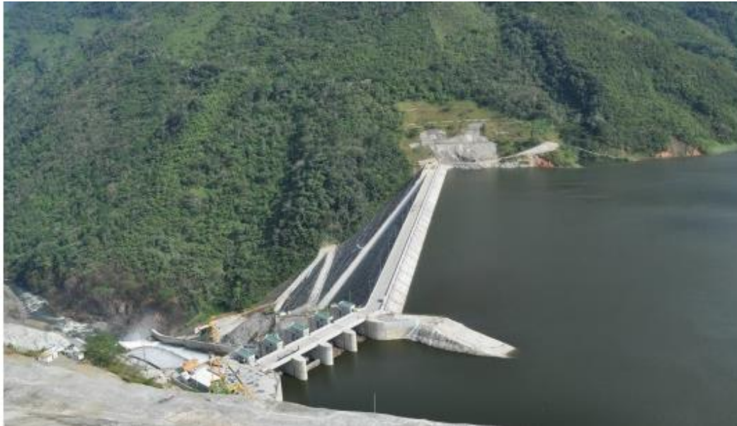
Fotografía 7-5 - Central hidroeléctrica Force III. Fuente: EPM
