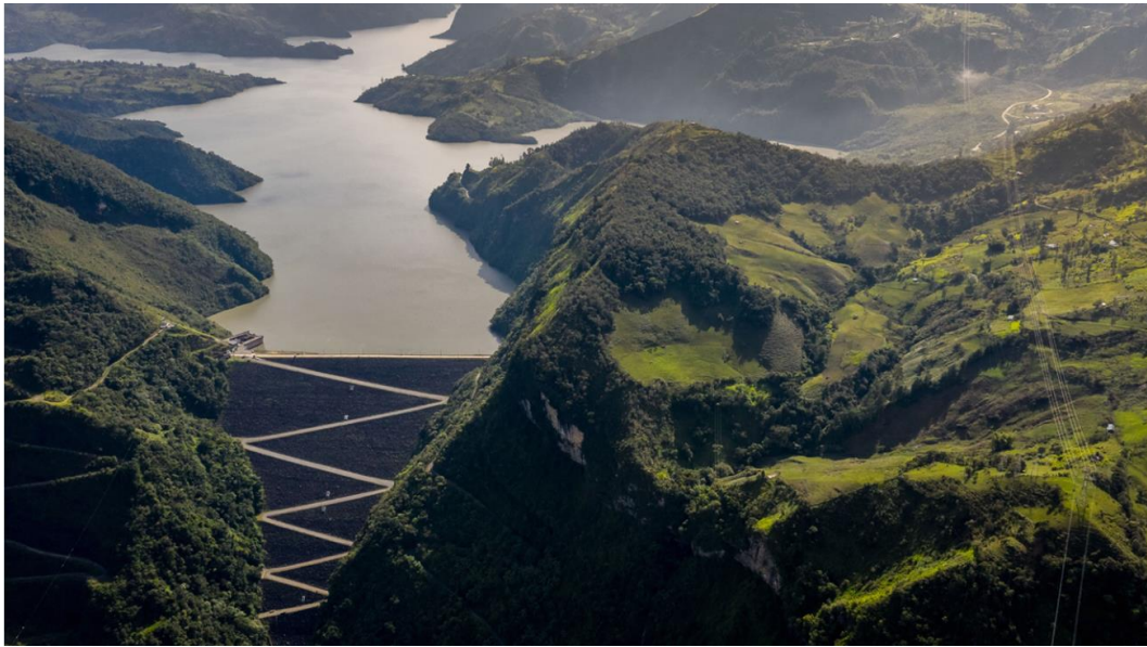
Fotografía 7-1 - Central hidroeléctrica Guavio. Fuente: Grupo Energía de Bogotá
