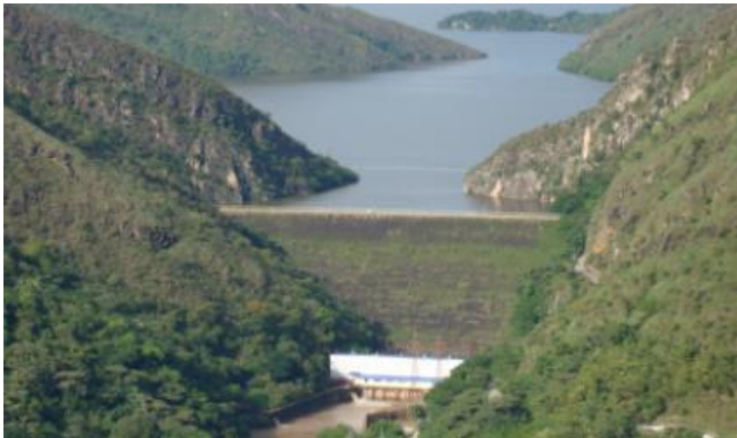
Fotografía 7-20 – Central hidroeléctrica Prado Fuente: Celsia
