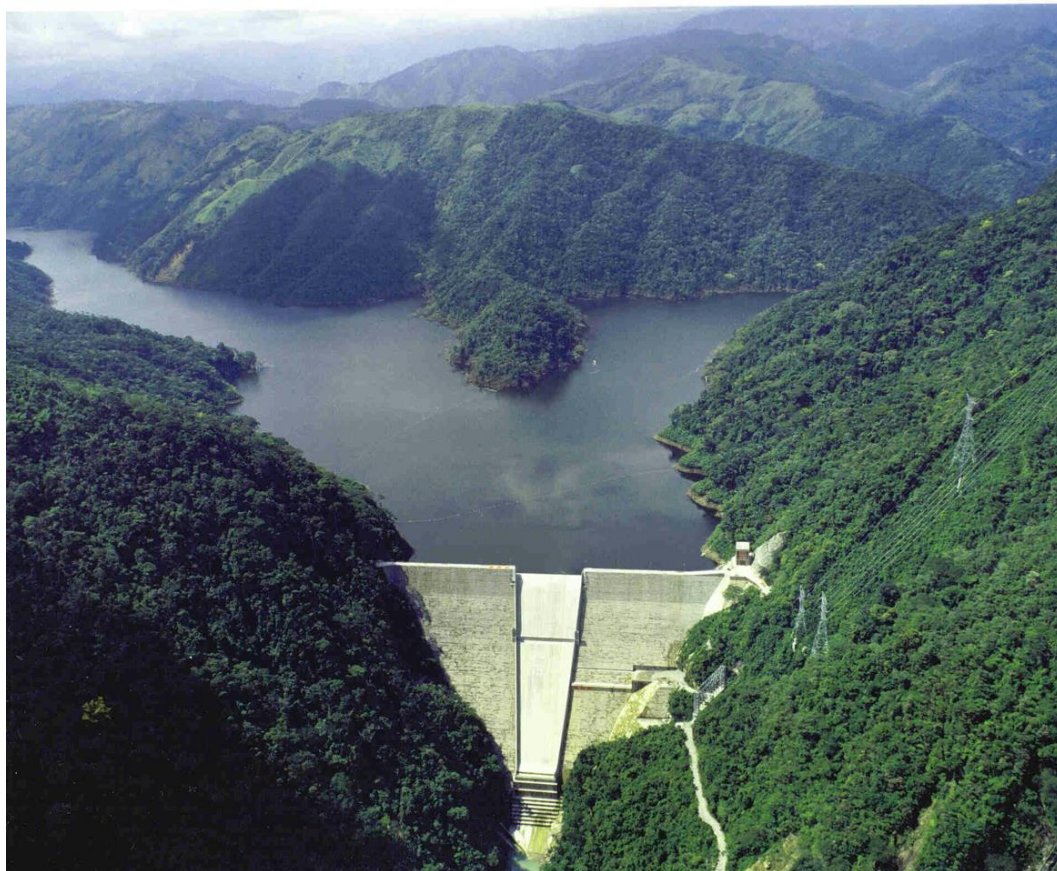
Fotografía 7-13 – Central hidroeléctrica Miel I. Fuente: Isagen
