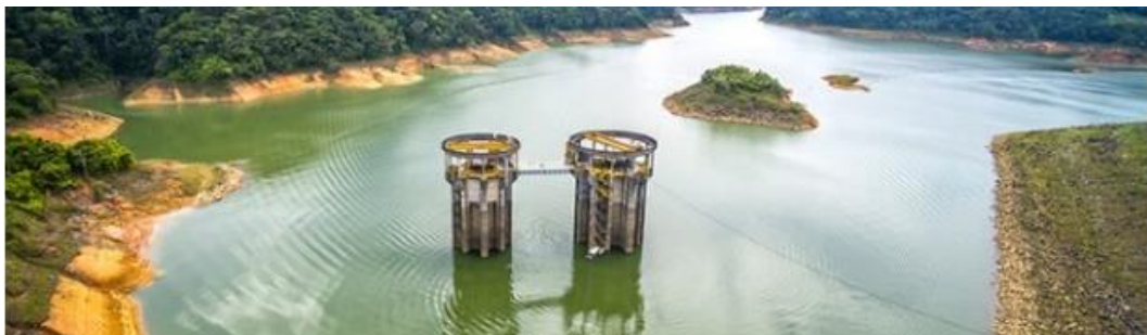
Fotografía 7-2 - Central hidroeléctrica San Carlos. Fuente: Isagen
