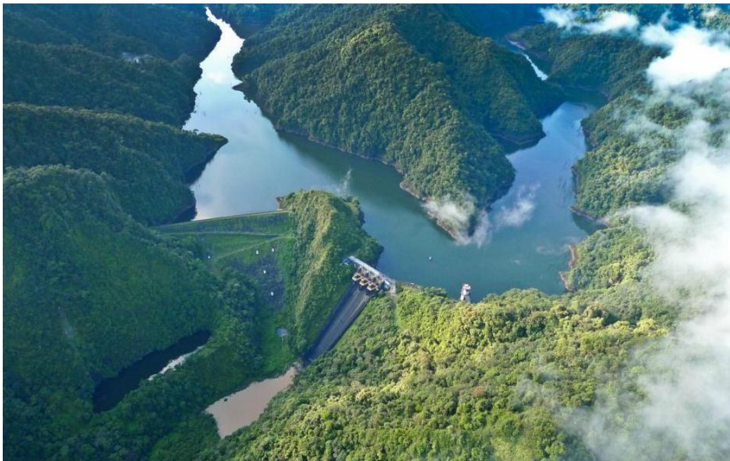
Fotografía 7-10 – Central hidroeléctrica Alto Anchicayá. Fuente: Celsia
