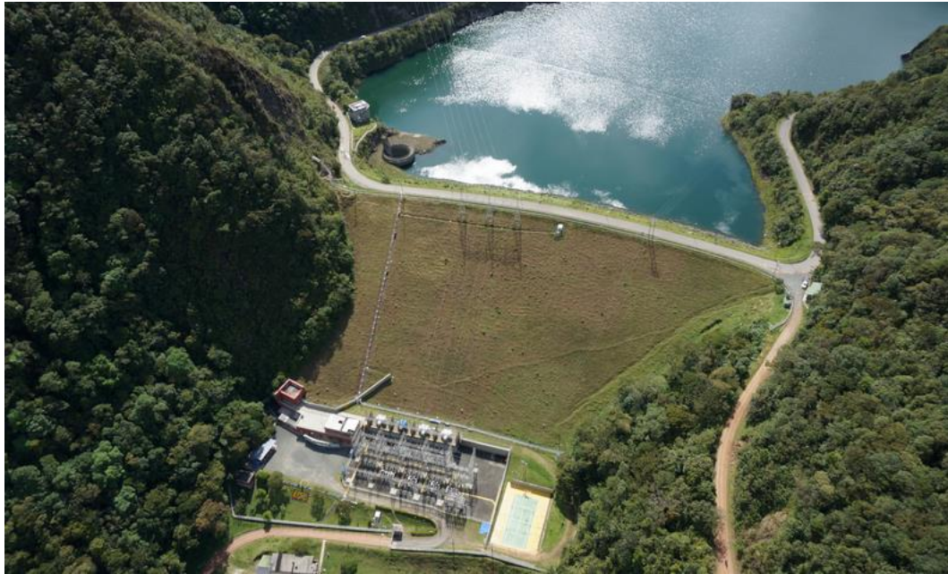
Fotografía 7-19 – Central hidroeléctrica Calima Fuente: Celsia
