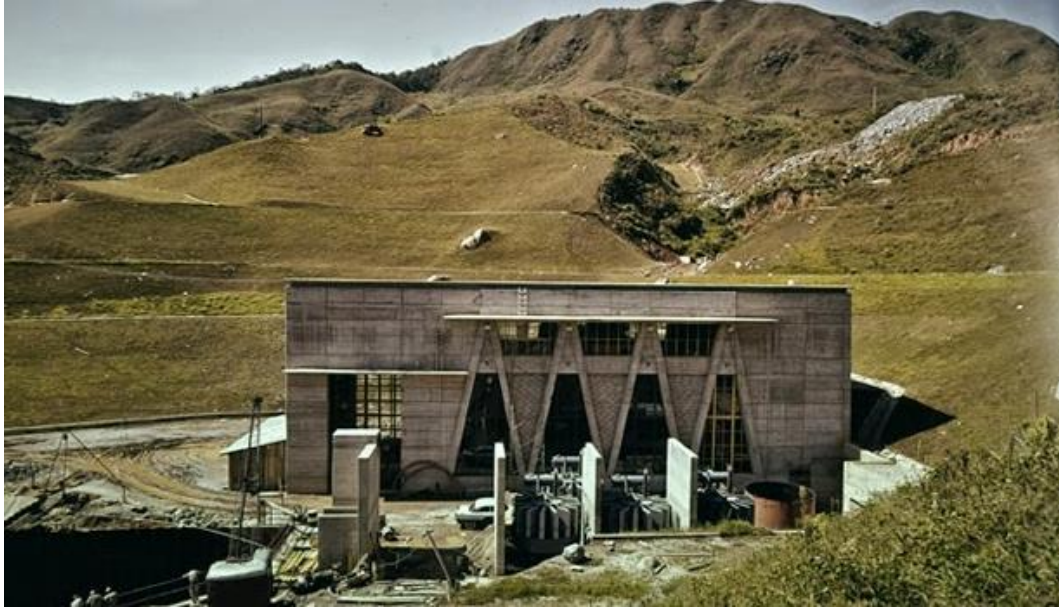
Fotografía 7-9 – Central hidroeléctrica Troneras. Fuente: EPM
