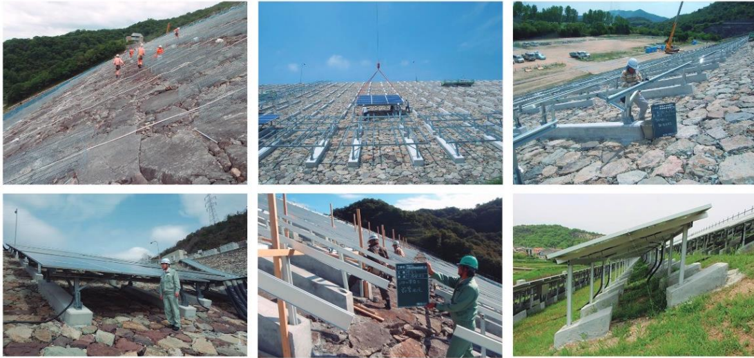
Fotografía 5-2 - Instalación de paneles solares en la presa Heiso en Japón
