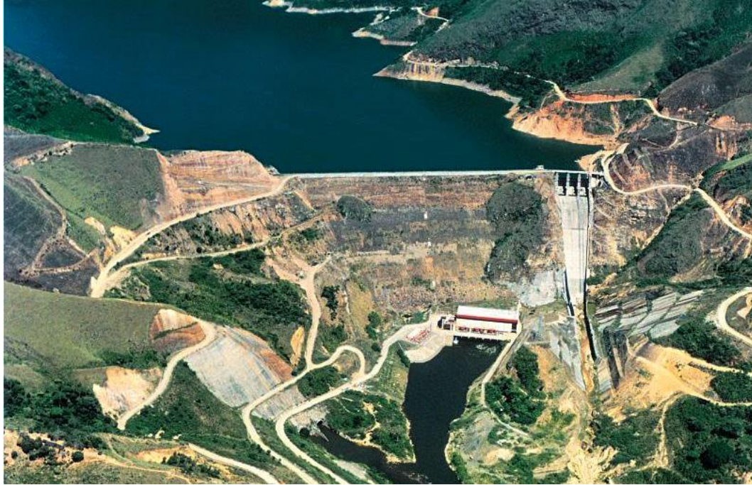
Fotografía 7-15 – Central hidroeléctrica Salvajina. Fuente: Conciviles S.A.
