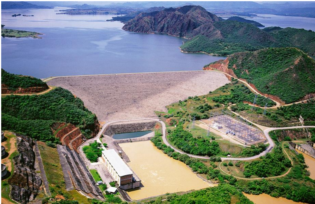
Fotografía 7-8 – Central hidroeléctrica Betania. Fuente: Enel
