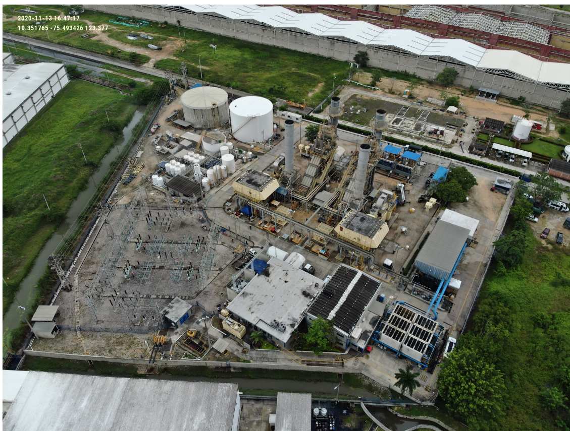
Figura 3-1.: Central de generación Proeléctrica (Fuente: Proeléctrica).
