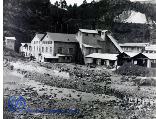
Planta hidroeléctrica El Charquito, Soacha (ca. 1898). Archivo General EEB. Fuente: Grupo de Energía de Bogotá . Se observa en primer plano (derecha) una fila de trabajadores que transportan materiales.
