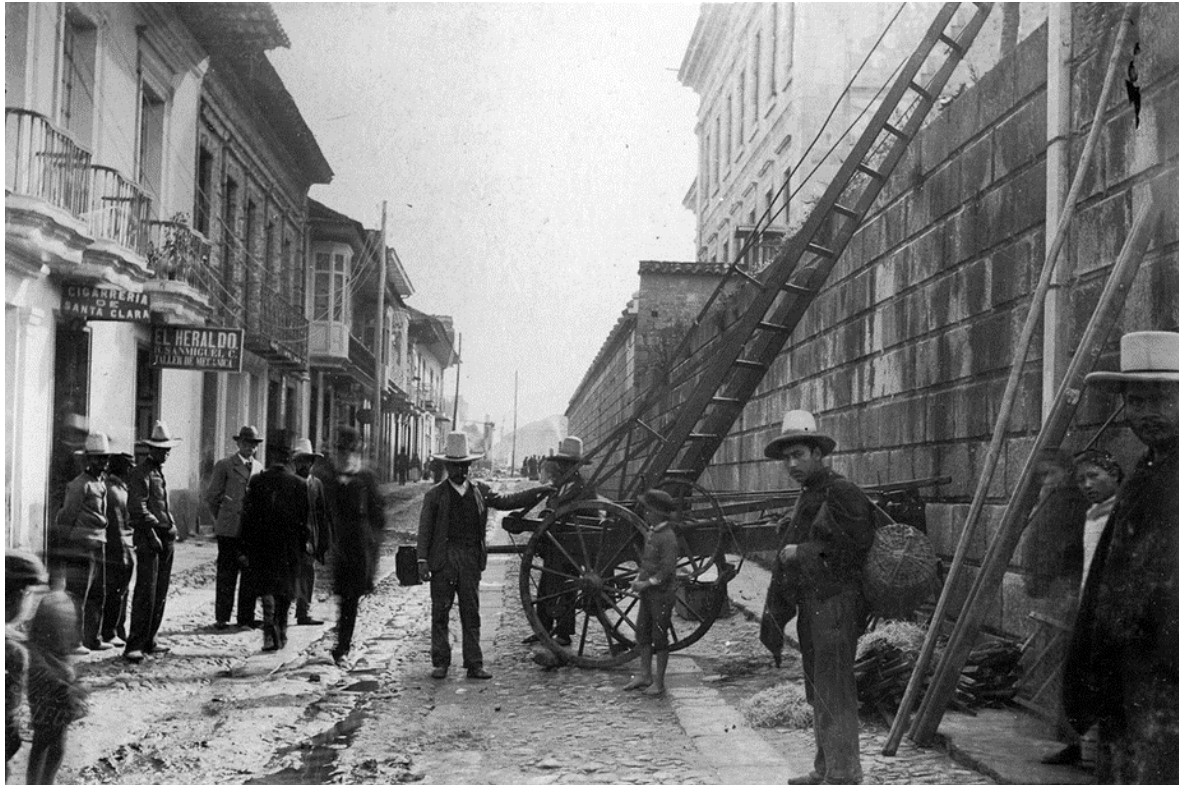
Obreros de la Samper Brush y Cía. instalan el cableado en el costado sur del Capitolio Nacional, ca. 1896. Fotografía. Colección Ernst Röthlisberger. Archivo Histórico Central Universidad Nacional de Colombia - Archivo de Bogotá.
