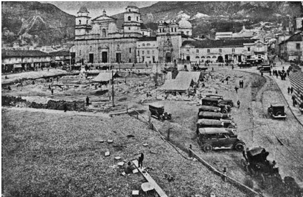
Trabajos de excavación en la Plaza de Bolívar para la construcción de las fuentes luminosas. Concejo de Bogotá,
