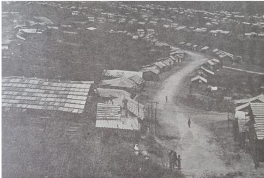
Figura 45: soluciones de vivienda autogestionada al pie del río, previa construcción del puente Pumarejo ( Barranquilla Gráfica , 1965)
