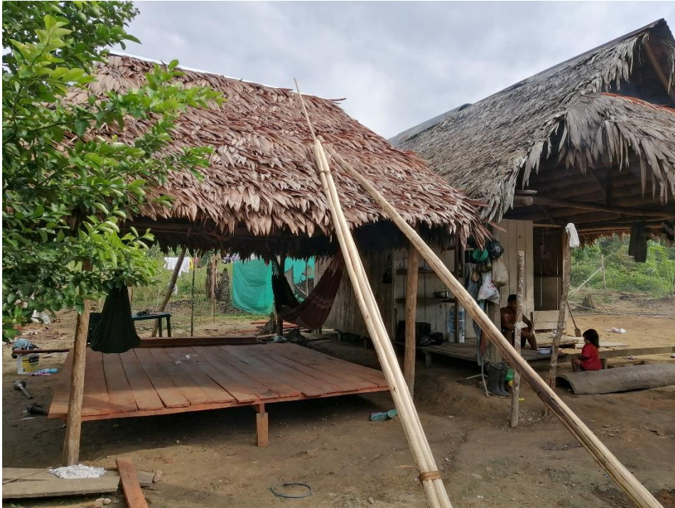
Foto 35: Yuly y Jairo amplían su vivienda en Moniya Amena (Antes).
