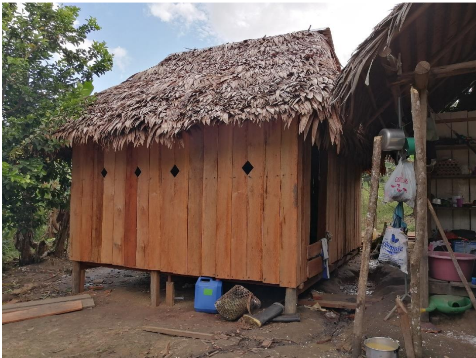
Foto 36: Yuly y Jairo amplían su vivienda en Moniya Amena (Después).
