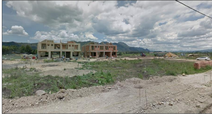
Figura 46: Conjunto residencial en construcción, V. Parcelas
