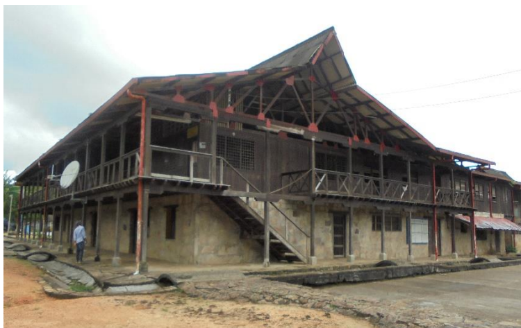
Fotografía 2. Casa Principal en la Chorrera
