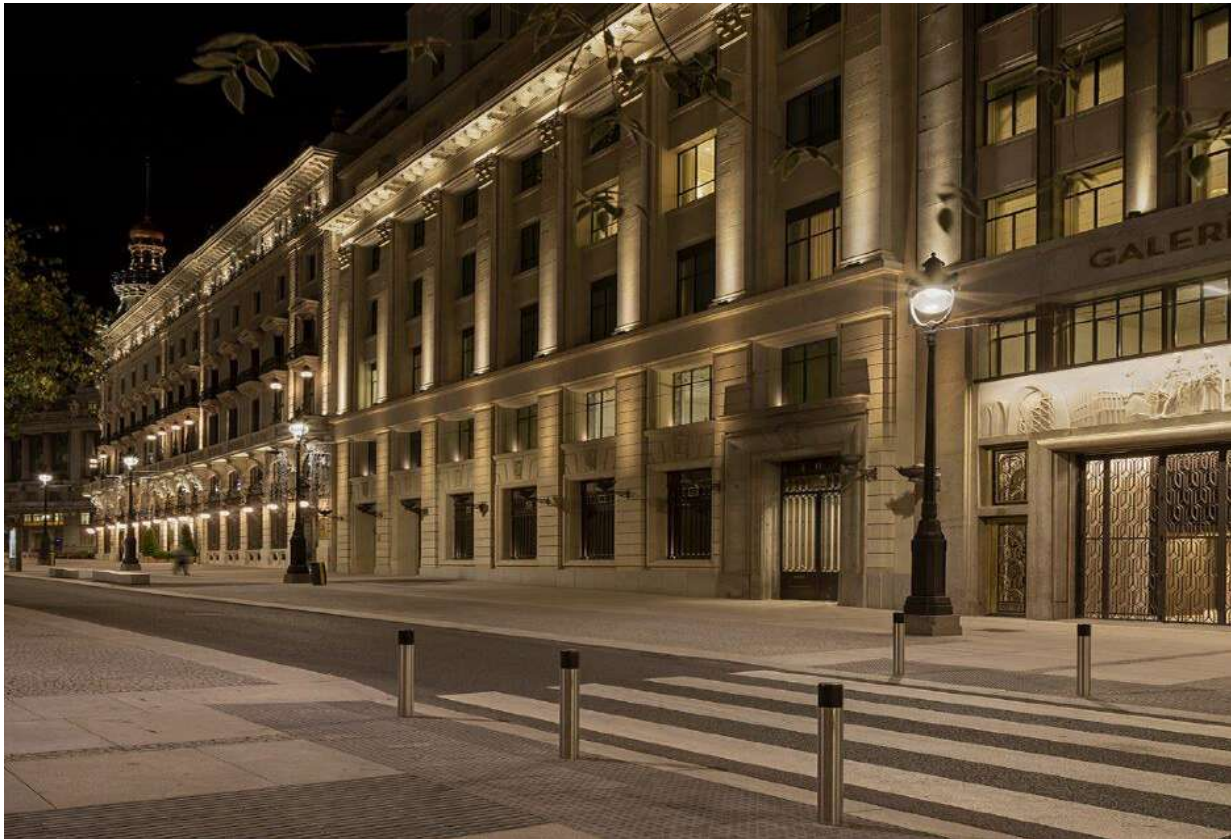
Figura 2-3 Centro Canalejas iluminación exterior lateral. (6)
