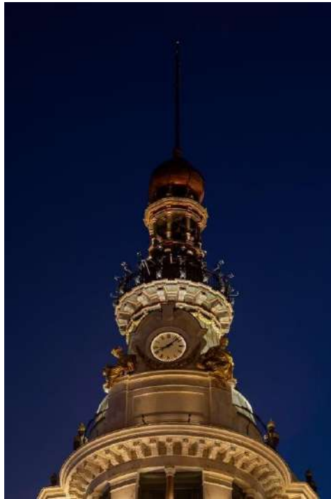
Figura 2-4 Centro Canalejas iluminación exterior superior (6)
