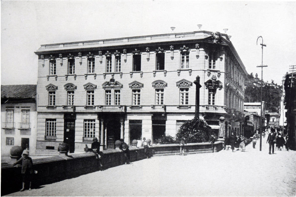
Edificio para el Sr. Enrique Gangotena. Russo Hermanos Arquitectos. El Ecuador en el centenario de la independencia de Guayaquil, 9 de octubre de 1920, Jurado, Aviles J.J. Editor New York, De Laisne & Carranza Duane Street.
