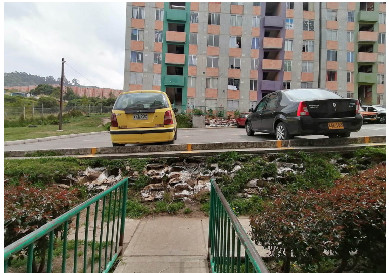
Figura 2. Barrio Colores de Bolonia I, Usme, Bogotá. Por la pendiente en la que se construyó, el primer piso está por debajo del nivel. Razón por la que suele inundarse. La inundación más importante ocurrió entre el 17 de diciembre de 2019 y el 10 de enero de 2020. Fotografía: Andrés Hincapié, 2020.
