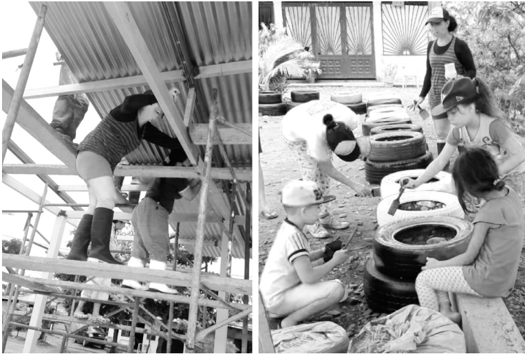
Figura 2. A la izquierda, autoconstrucción del salón comunal; a la derecha, el parque principal de la comunidad del barrio El Girasol. Fotografía: Daniel López, 2019.
