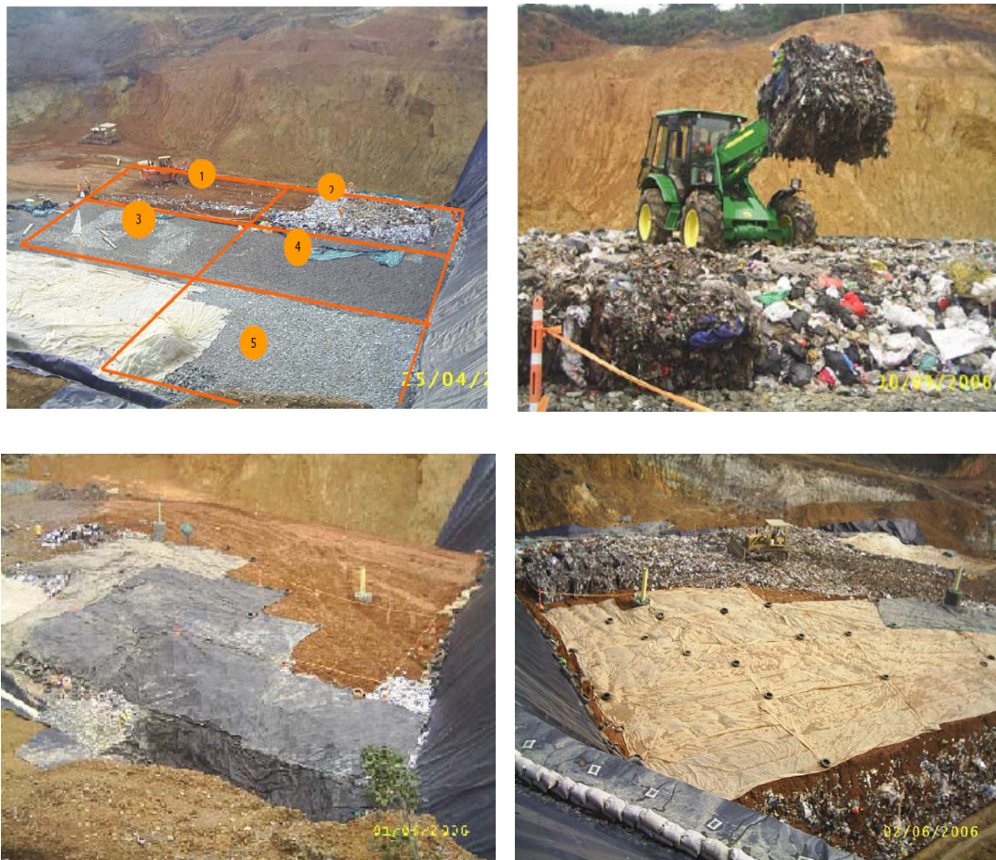
Figura 22. Conformación de celdas, disposición de fardos y cobertura de los residuos sólidos Fuente: ARES (2006).
