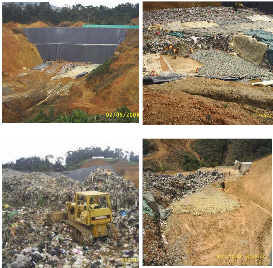
Figura 23. Adecuación inicial del vaso norte del relleno sanitario simultánea a la disposición de los residuos sólidos y conformación de las capas de residuos sólidos Fuente: ARES (2006).
