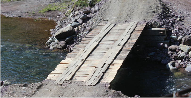
Puente de palotigre y palo blanco
