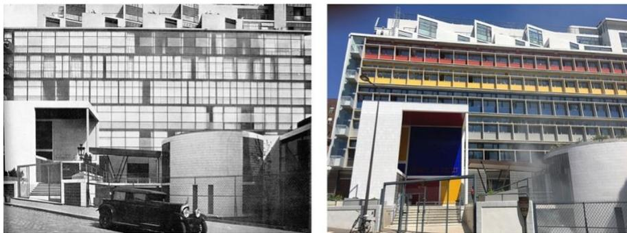
Ilustración 52. Le Corbusier, Armée du Salut, Cité de Refuge, París, 1929-33. El edificio antes y después de la incorporación del brise-soleil (*Œuvre complète / Le Corbusier et Pierre Jeanneret*, 2013, vol. 2, pág. 99; Fotografía del estado actual: J. Mantilla, 2018).
