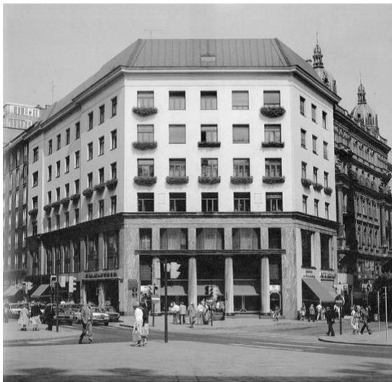
Ilustración 88. A. Loos. Edificio en Michaelerplatz, Viena, 1909-10. Columnas sin función estructural, pero como elementos de resolución del conflicto de fuerzas sobre el eje vertical (Gravagnuolo, 1988, pág. 127).
