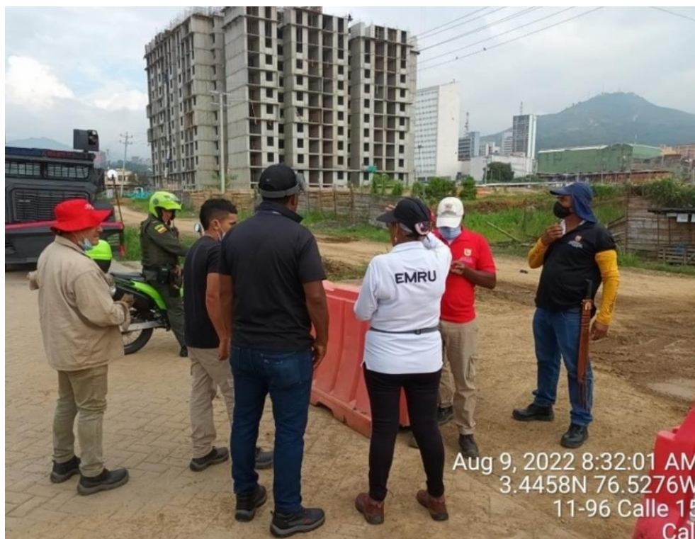
Ilustración 3-8. Torre de vivienda en construcción plan parcial El Calvario
