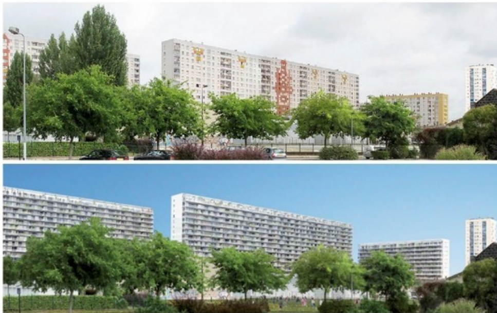
Bâliments H,I - montées 1,3 et 5 - étage courant
