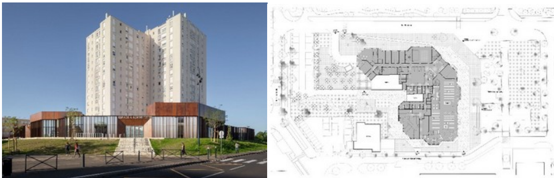
Figura 2-29: Centro Comunitario Albert Schweitzer, Dammarie, Francia. Mao Architectes, 2019
