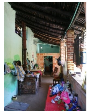
Figura 440. Columnas de galería en ladrillo tolete, caso 12.
