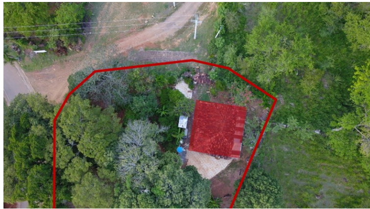
Figura 161. Edificación exenta al interior de la parcela.
