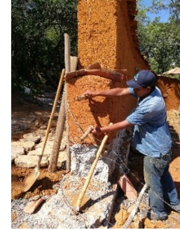
Figura 593. Inserción de colmillos entre juntas horizontales. Guane.
