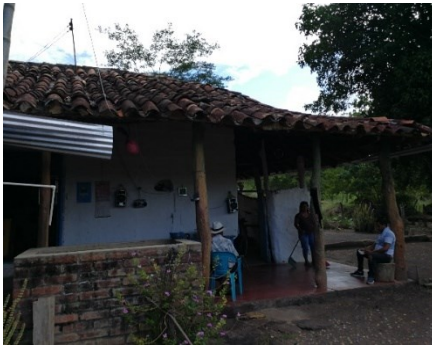
Figura 88. Canal de latón improvisado para la recolección de aguas lluvias, caso 2.
