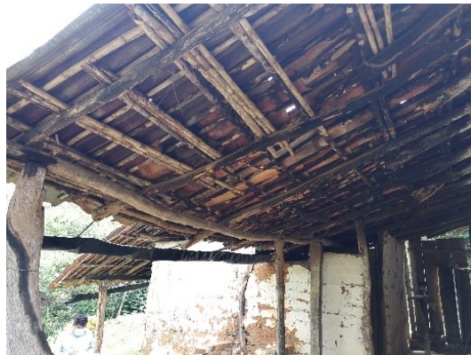
Figura 638. Techo engaverado en vivienda de bahareque, caso 10.
