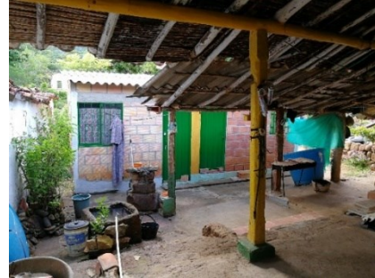
Figura 569. Puertas y ventana metálica en nueva construcción, caso 16.
