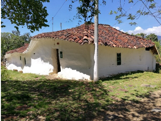
Figura 131. Construcción habitada por dos familias, caso 18.
