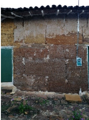
Figura 466. Muro de tapia pisada de 4 hiladas, caso 14.
