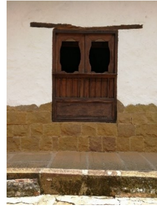
Figura 732. Nueva carpintería de madera y barras hierro, caso 11.
