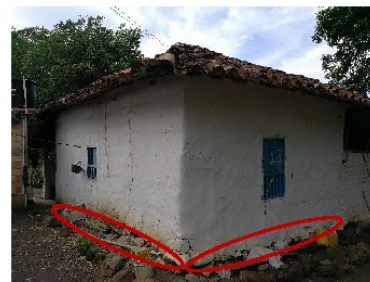
Figura 695. Bahareque con erosión física en sobrecimiento, caso 2.
