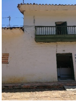
Figura 173. Casa esquinera con balcón, caso 20.
