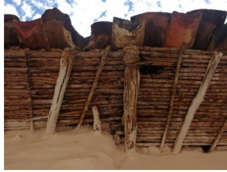
Figura 534. Teja artesanal sobresaliendo del alero, caso 15.
