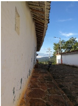
Figura 539. Pañete tradicional sobre fachadas, caso 1.
