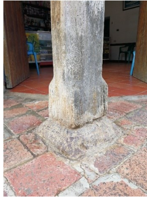
Figura 498. Pedestal de piedra y basa de la rinconada, caso 21.
