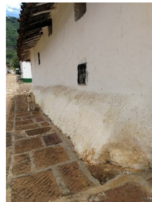
Figura 613. Sobrecimiento adosado a forma de zócalo piramidal, caso 15.
