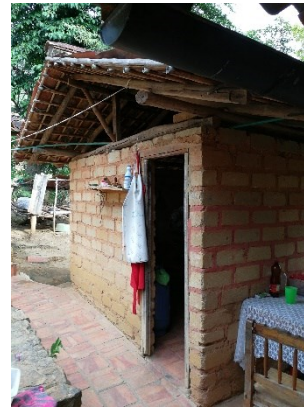
Figura 736. Construcción nueva con bloques de tierra comprimida.
