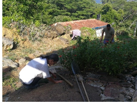
Figura 738. Trabajo comunitario de mantenimiento de calle de piedra.
