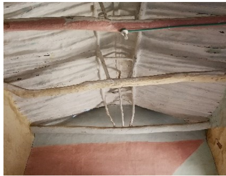
Figura 525. Nudillos y vigas paralelas a la cumbreira, caso 11.
