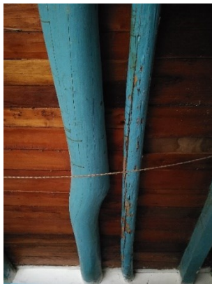
Figura 76. Vigas de entrepiso en madera de nauno.
