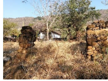
Figura 36. Caso 23, casco urbano, ruina de horno en chircal.
