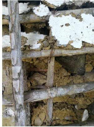
Figura 618. Amarre de elementos con alambre negro.
