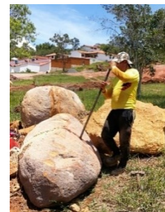
Figura 448. Separación de piedra con barra manual, Barichara.
