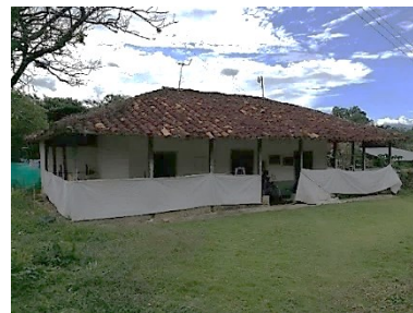
Figura 201. Techo unificado sobre el cuerpo central y las galerías de la construcción, caso 4.
