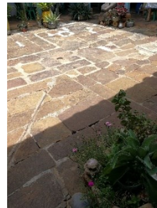
Figura 549. Piso de piedra en diversos formatos, caso 11.
