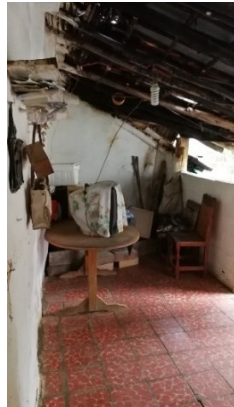
Figura 213. La galería sirve como espacio social familiar, caso 18.
