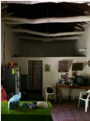
Figura 238. Espacios divididos por un muro a media altura, caso 5.
