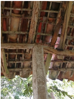
Figura 536. Techo engaverado sobre casa de habitación, caso 10.
