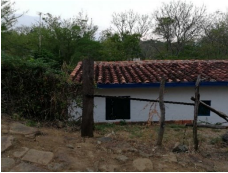
Figura 727. Reutilización de tejas antiguas en construcción reciente, casa Claudia Ruíz.
