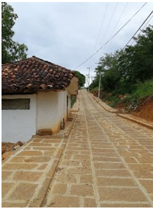
Figura 102. Calle principal adecuada en piedra hacia los años 40.
