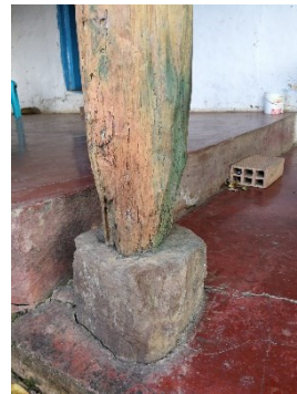
Figura 495. Pedestal de piedra con orificio y espigo.
