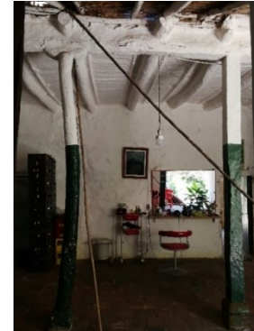
Figura 256. Estructura de entrepiso en madera, caso 20.
