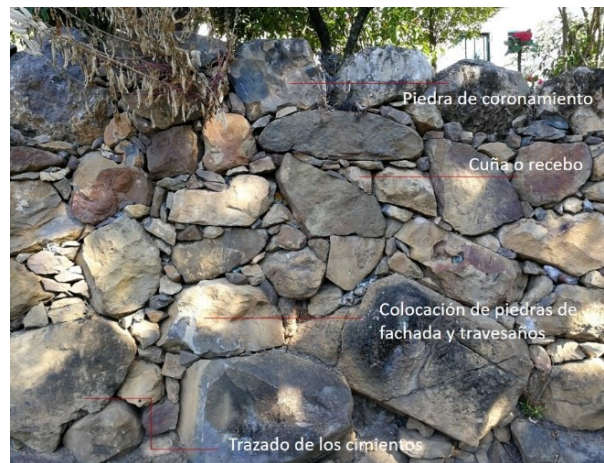
Figura 667. Trazado de las primeras hiladas.
