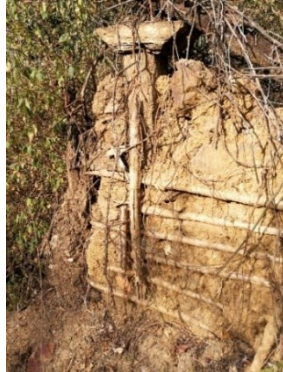
Figura 365. Ruinas de construcción en bahareque embutido, caso 19.
