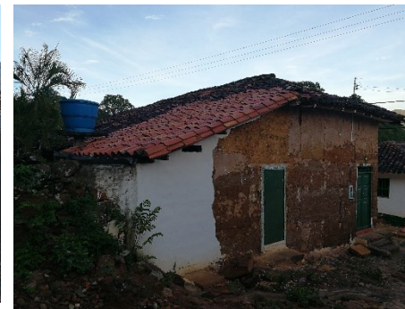
Figura 93. Tanque aéreo y baño al interior del patio, caso 14.
