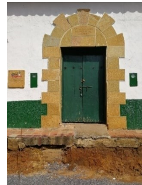
Figura 363. Enchape en piedra en portón de la Casa de la Cultura.
