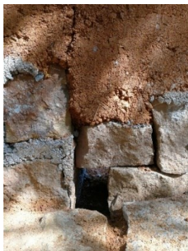
Figura 582. Cimiento realizado de la superficie del terreno. Guane.
