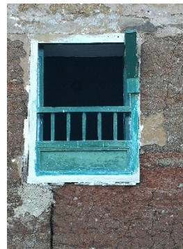
Figura 579. Ventana con barandal de bolillos cuadrados, caso 14.
