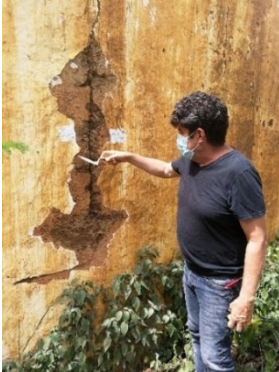
Figura 364. Inspección de unión entre tapias, caso 13.
