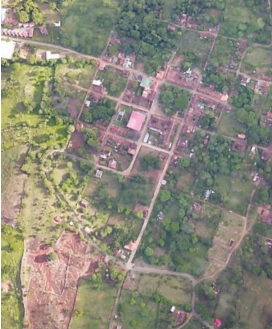
Figura 48. Aerofotografía de la cabecera municipal.
