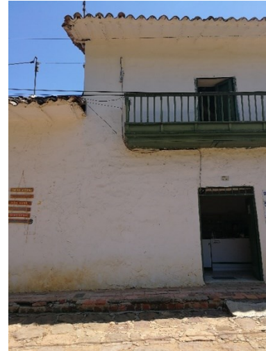
Figura 504. Construcción esquinera con balcón, caso 20.
