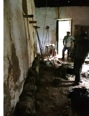
Figura 5. Obras de reparación de muros en tapia pisada.
