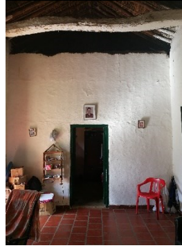
Figura 552. Piso en tableta industrial de gres, caso 8.
