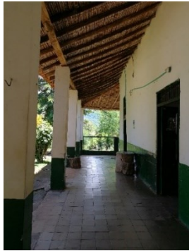
Figura 729. Sustitución de pies derechos de madera por machones de ladrillo tolete, caso 6.
