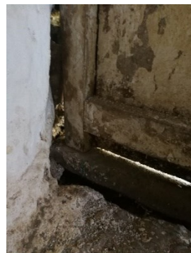
Figura 559. Detalle del pivote en el umbral de la puerta, caso 9.
