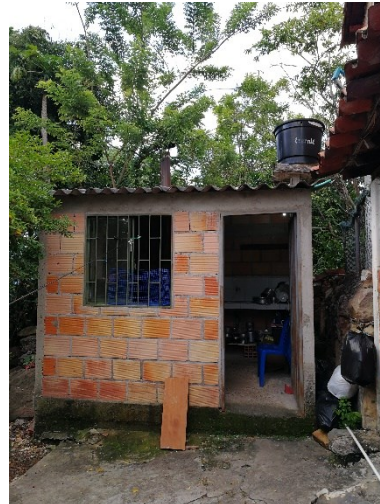
Figura 272. Cocina exenta en programa de mejoramiento de vivienda.
