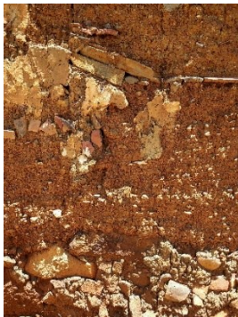
Figura 400. Muro de tierra con el sistema de tapia pisada.
