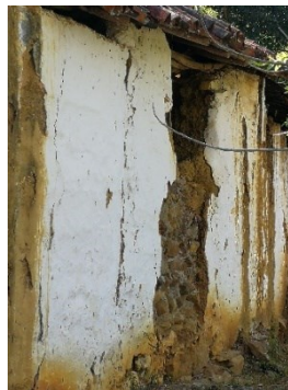
Figura 513. Soleras de madera rolliza sobre muro de tapia pisada.
