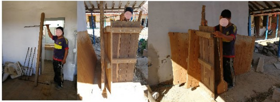
Figura 584. Secuencia de fotografías de elementos del tapial. Guane.
