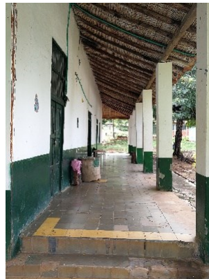
Figura 501. Columna de ladrillo tolete de sección cuadrada y pañetada, caso 6.
