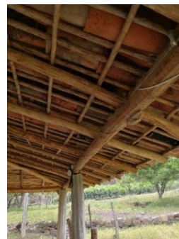
Figura 425. Telar de techo en cañabrava engaverado, caso 13.
