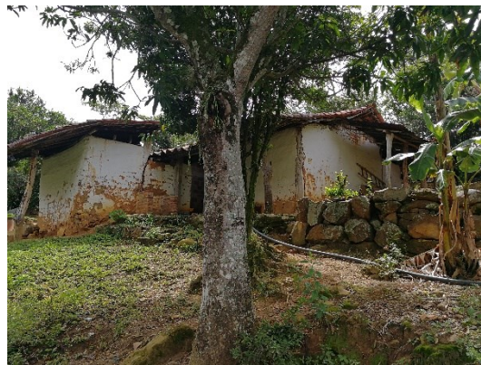
Figura 58. Construcción de bahareque en la cima de una colina.
