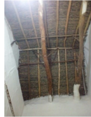
Figura 369. Techo impermeabilizado, caso 20.
