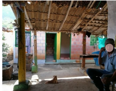
Figura 730. Extensión de galería con tejas de zinc y fibrocemento, caso 16.
