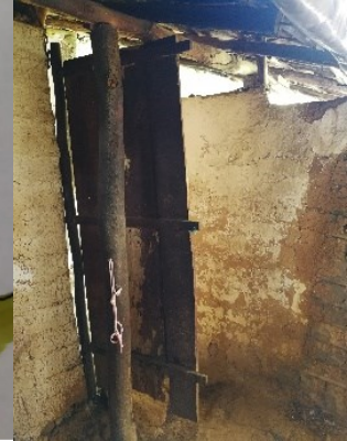
Figura 637. Paral para trancar la cubierta, caso 10.
