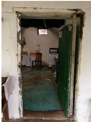
Figura 645. Puerta de pivote sobre muro de bahareque, caso 15.
