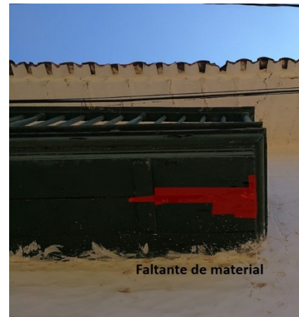
Figura 710. Lesiones por la cara inferior del balcón, caso 20.
