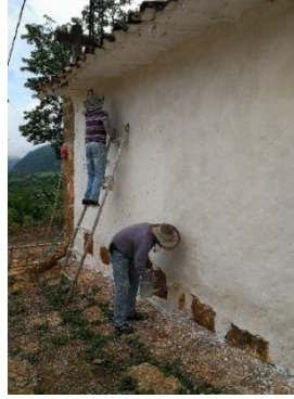
Figura 444. Pintura con cal apagada.
