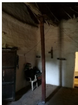
Figura 262. Espacio original subdividido con muro de bahareque.
