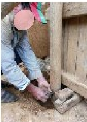
Figura 585. Nivelación y aplomado de tapiales. Barichara.
