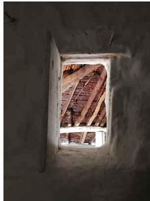
Figura 646. Ventana mínima sobre muro de bahareque, caso 18.
