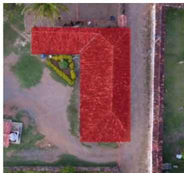
Figura 159. Edificación aislada rural en paramento sobre la vía.
