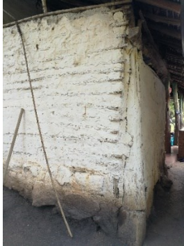
Figura 653. Muros de bahareque de diversos espesores, caso 2.
