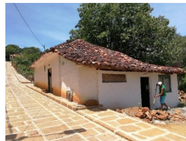
Figura 113. Casa esquinera rodeada de espacios abiertos.
