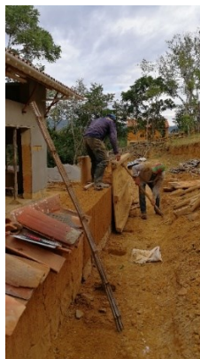
Figura 594. Protección provisional de muros. Barichara.
