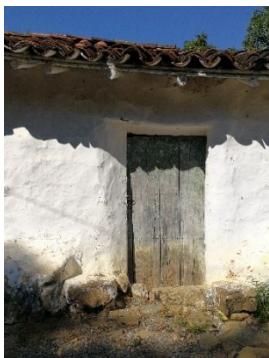
Figura 557. Cara externa de la puerta con pivote.
