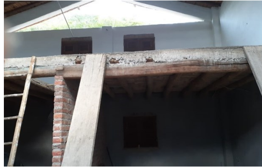
Figura 728. Reutilización de viga de madera cepillada en construcción reciente, casa Machamanga.
