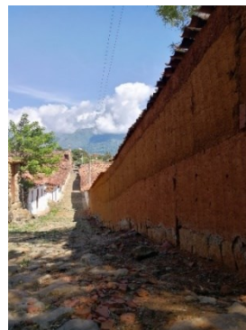
Figura 583. Cimiento y muro de cerramiento. Guane.
