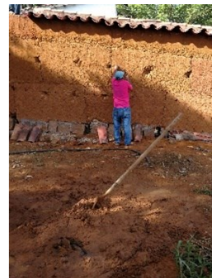
Figura 596. Sellamiento de mechinales dejados por el retiro de las riostras de la formaleta.
