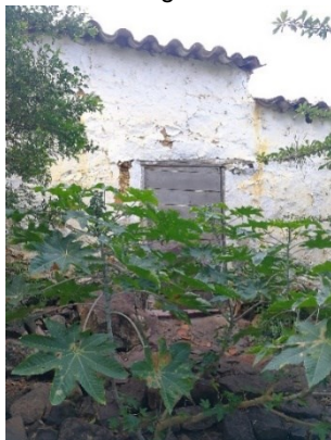
Figura 324. Entrada posterior a patio secundario, caso 11.
