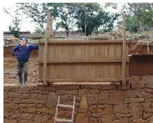
Figura 587. Tapial preparado para continuar la construcción del muro. Barichara.
