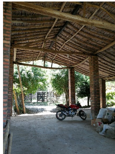
Figura 276. Edificio de planta libre rectangular usado como molino de grano y corral, caso 5.
