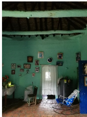
Figura 548. Piso de gres artesanal en colocación regular, caso 12.
