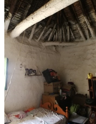
Figura 625. Apariencia interior del bahareque embutido, caso 15.
