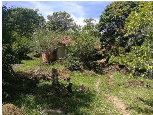
Figura 73. El edificio rural, rodeado de vegetación, caso 9.
