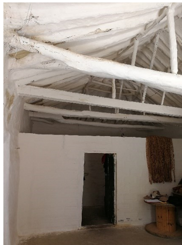
Figura 274. Armadura de techo en casa de bahareque, caso 18.
