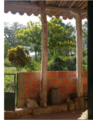
Figura 464. Cimiento aislado y bordillo en piedra, caso 8.
