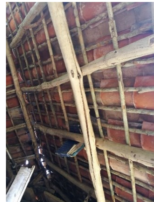
Figura 538. Techo engaverado sobre troja, caso 18.
