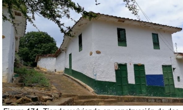
Figura 174. Tienda y vivienda en construcción de dos pisos.
