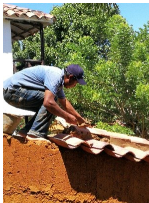
Figura 595. Colocación de tejadillo sobre muro de cerramiento.
