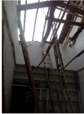
Figura 368. Cambio de piezas de la armadura, caso 20.
