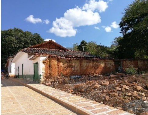
Figura 351. Demolición de sección de casa en tapia pisada.
