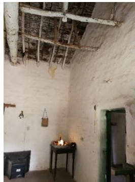
Figura 540. Pañete tradicional sobre muros internos y armadura de cubierta, caso 16.
