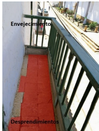
Figura 709. Lesiones por la cara superior del balcón, caso 20.
