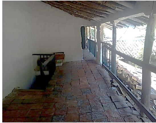
Figura 507. Entrepiso desde el segundo nivel, caso 20.
