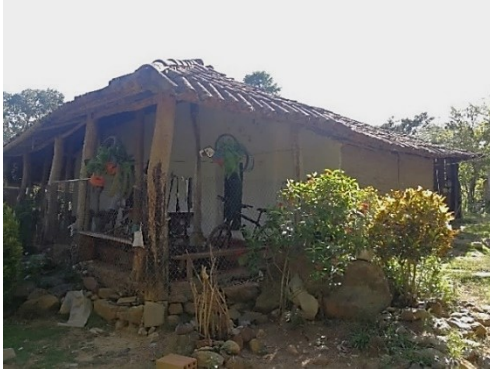
Figura 207. Casa de bahareque con galerías de madera.
