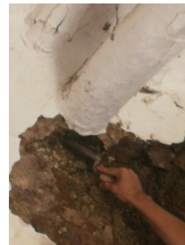
Figura 514. Solera de piedras entre el tapial y el tirante, caso 14.
