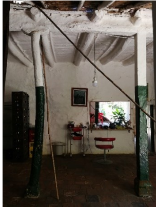
Figura 731. Sustitución de pie derecho de fuste tallado, caso 20.
