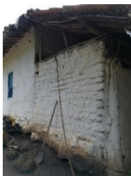
Figura 632. Pie derecho de galería usado para muro de bahareque, caso 5.
