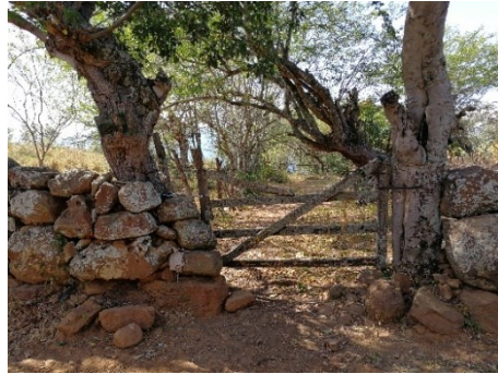
Figura 662. Árboles y jambas de piedra en portillo de entrada.
