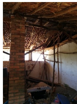
Figura 439. Columna central en ladrillo tolete, caso 14.
