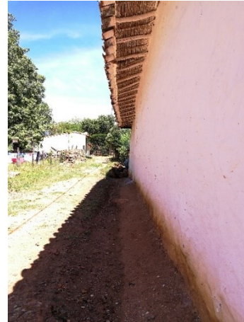
Figura 218. Muro exterior de la galería en una casa urbana, caso 2
