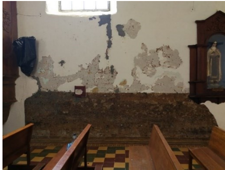
Figura 354. Restitución de zócalos con pintura mural por pañetes de cemento en la Iglesia.
