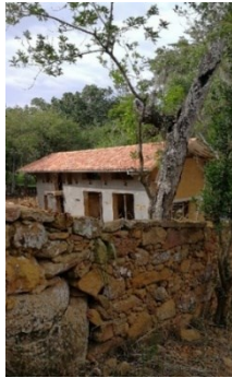
Figura 357. Cercado en piedra construido en Barichara, 2018.
