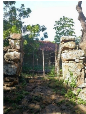
Figura 752. Portal de piedra.
