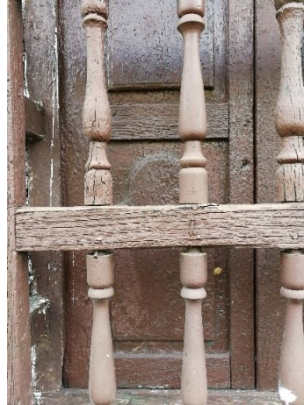
Figura 724. Envejecimiento de ventana de madera pintada en esmalte.
