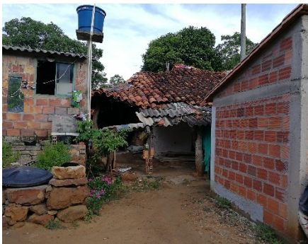
Figura 91. Tanque aéreo, al interior del solar, caso 16.
