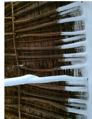
Figura 532. Unión de canes y pares en el alero, caso 15.
