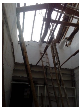
Figura 598. Utilización de tirantes existentes y nuevos pares en madera.
