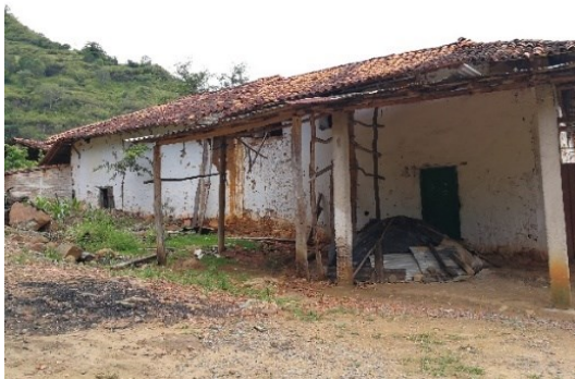
Figura 248. Casa de hacienda en la vereda Los Colorados.
