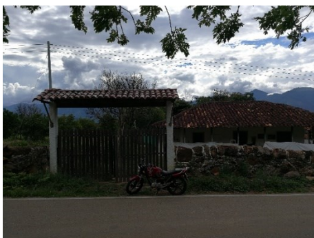
Figura 120. Construcción vernácula sobre la vía departamental San Gil a Cabrera, caso 4.
