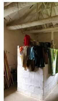
Figura 263. Espacio subdividido con muro de bloque a media altura.
