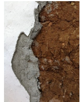
Figura 542. Pañete de arena y cemento retirado de la fachada, caso 14.
