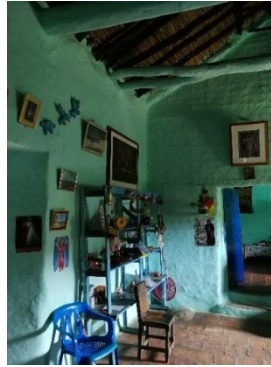
Figura 255. Muros de tapia pisada con cal pigmentada, caso 12.
