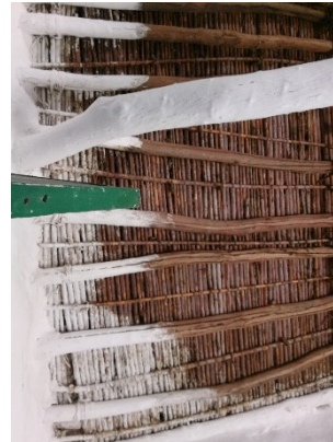
Figura 523. Pares de madera rolliza, caso 15.
