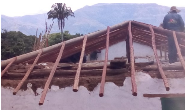
Figura 597. Estructura de techo apoyado sobre soleras encima de los muros de tapia.
