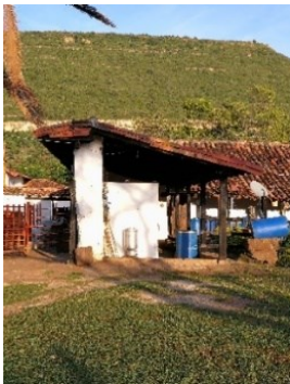
Figura 309. Baño en el extremo de una galería, caso 1.
