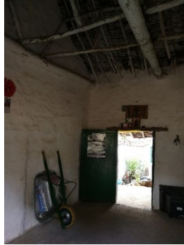
Figura 654. Construcción antigua en bahareque, caso 16.
