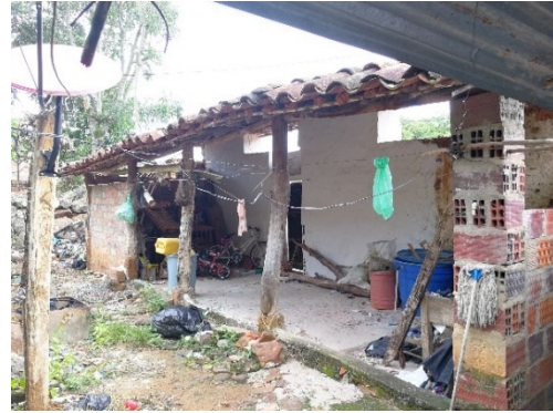
Figura 332. Cerramiento del extremo de la galería, caso 15.
