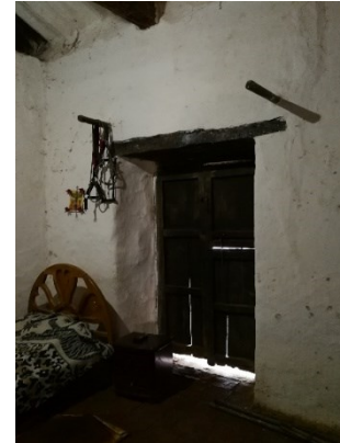
Figura 468. Muro grueso de tapia, caso 1.
