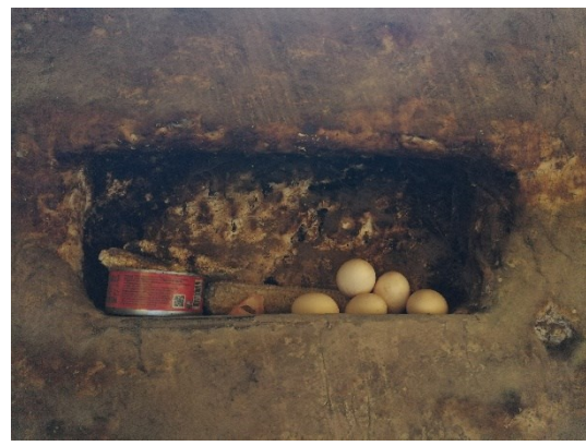
Figura 650. Nicho excavado en el muro de bahareque, caso 17.
