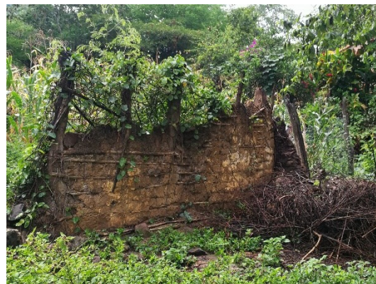
Figura 610. Serie de estantillos anclados a cimentación de piedra.
