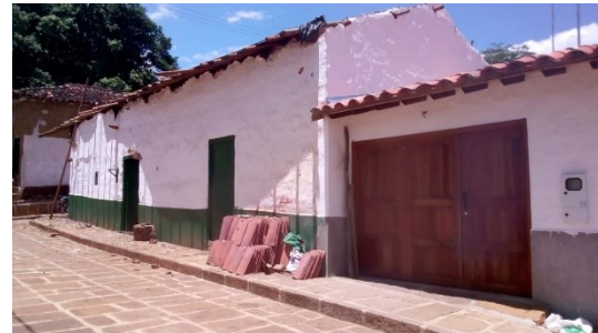
Figura 371. Cambio de techo y construcción de uno nuevo.
