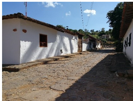
Figura 154. Calle principal con muros alineados blanqueados con cal.
