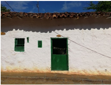
Figura 488. Puerta con jambas rectas.
