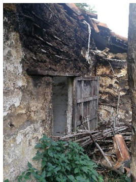
Figura 558. Cara interna de la puerta con pivote, caso 13.
