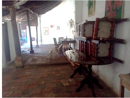
Figura 259. Galería sobre patio central, caso 20.
