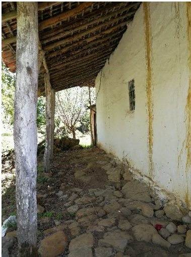
Figura 223. Interior de galerías en forma de "U", caso 9.
