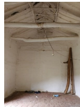
Figura 476. Hastial aligerado con bahareque, caso 13.
