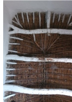
Figura 516. Tirantes entre muros laterales, caso 1.
