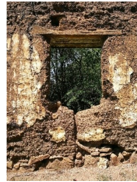
Figura 427. Colmillos de cañabrava (internos) entre uniones de tapiales.
