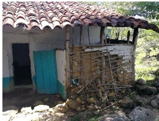
Figura 37. Casa de bahareque autoconstruida, caso 9.
