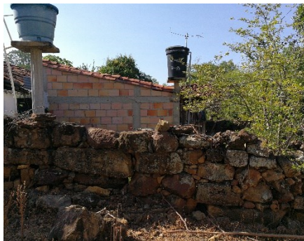
Figura 335. Adaptación de tanques y redes hidráulicas, caso 18.
