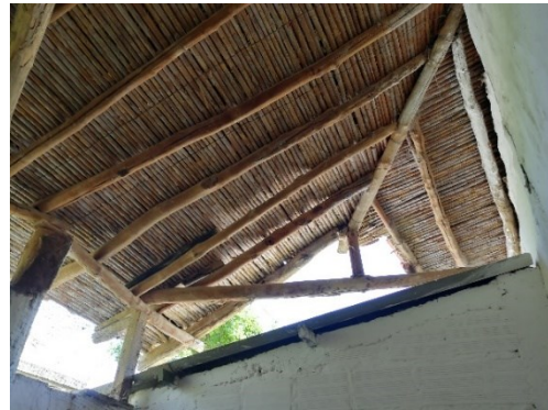
Figura 429. Cañabrava amarrada con alambre negro y puntilla, caso 3.
