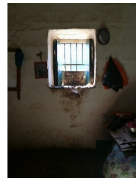
Figura 573. Ventana con rejas de ancho inferior al muro de tapia, caso 17.
