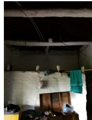
Figura 71. Espacio interior separado por tabique a media altura, caso 2.
