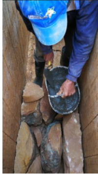
Figura 591 Colocación de base de piedra sobre el cemento. Barichara.
