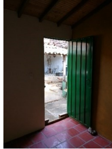
Figura 568. Puerta metálica en muro de bloque aligerado, caso 16.
