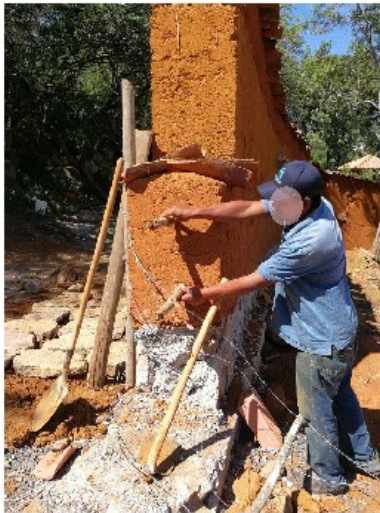
Figura 470. Colocación de colmillos entre unión de tapias, Guane.
