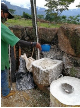
Figura 443. Proceso de apagado de la cal en roca, caso 1.
