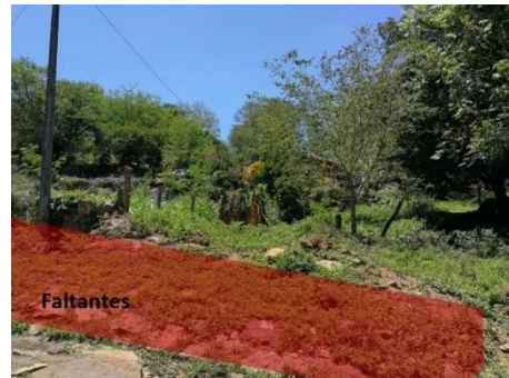
Figura 705. Cercado de piedra demolido, caso 19.
