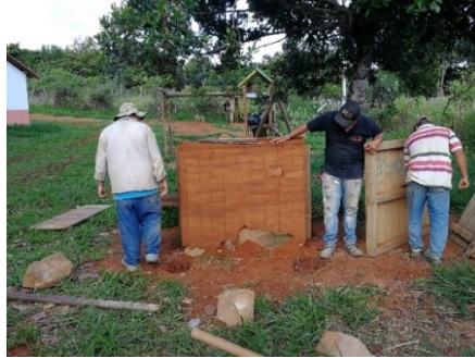
Figura 592. Tapiales terminados con mezclas homogénea. Barichara.
