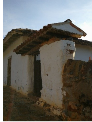
Figura 280. Portal en construcción rural, caso 1.
