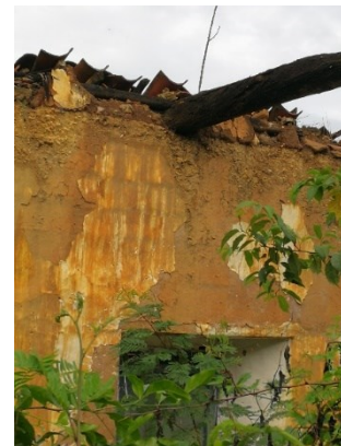
Figura 602. Tirante apoyado sobre muro.
