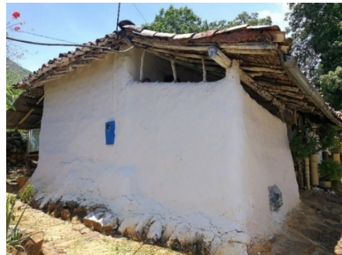
Figura 69. Hastial abierto para circulación permanente del aire.
