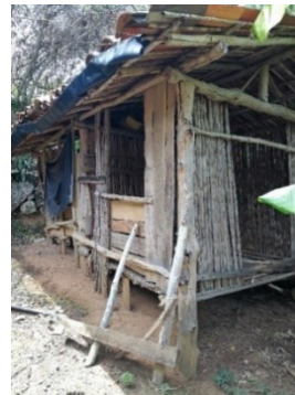
Figura 179. Planta de troja en madera y cañabrava, caso 8. Figura 180. Troja con entresuelo ventilado.
