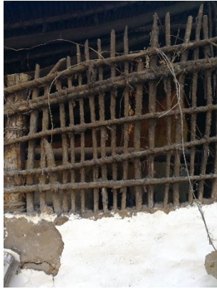
Figura 617. Amarre de elementos con fiquetón.
