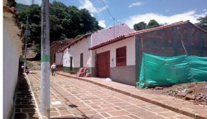
Figura 352. Nueva construcción imitando el lenguaje arquitectónico de antaño.
