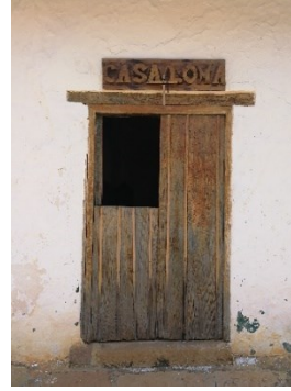
Figura 563. Puerta de bisagra de dos hojas y una dividida horizontalmente, caso 1.
