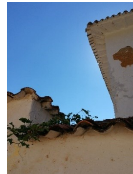
Figura 403. Tejas adheridas con mezclas de tierra.
