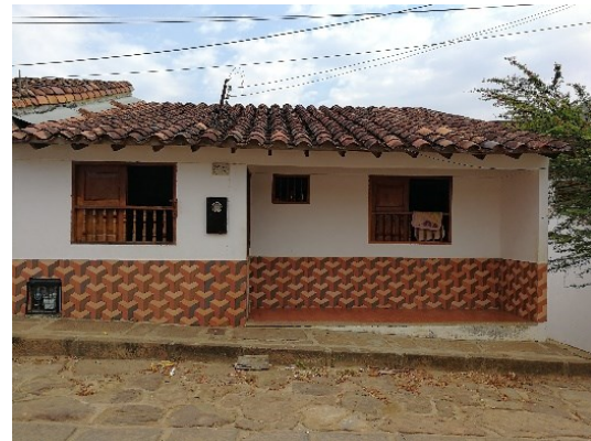
Figura 391. Vivienda parecida a las construcciones vernáculas.
