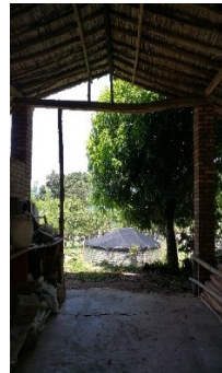
Figura 86. Tanque de almacenamiento de agua, caso 5.
