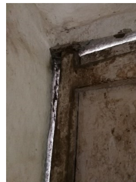
Figura 560. Detalle del pivote en el dintel de la puerta, caso 9.
