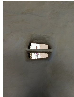
Figura 647. Perforación en muro de bahareque para observar la entrada principal, caso 18.
