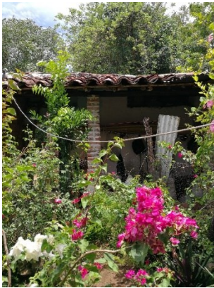
Figura 80. Patio interior, caso 12.
