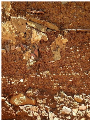
Figura 600. Material granular en muro de tapia pisada.
