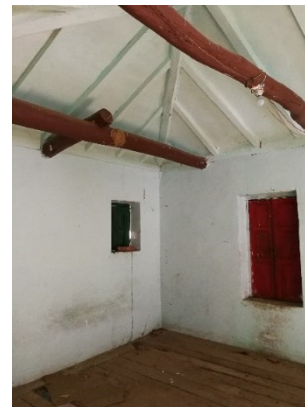
Figura 77. Armadura de cubierta en maderas de nauno y cucharo.
