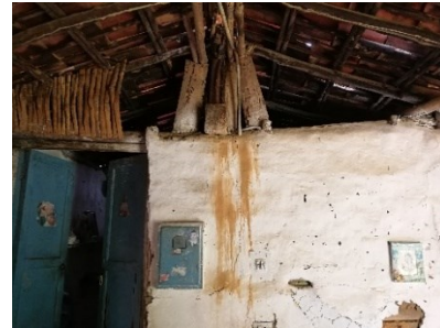
Figura 631. Hastial abierto entre muros divisorios, caso 10.
