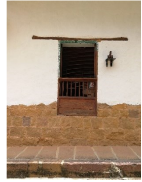
Figura 553. Revestimiento de zócalo en piedra, caso 11.
