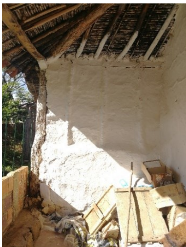
Figura 61. Sobrecimiento en piedra a manera de zócalo, caso 8.
