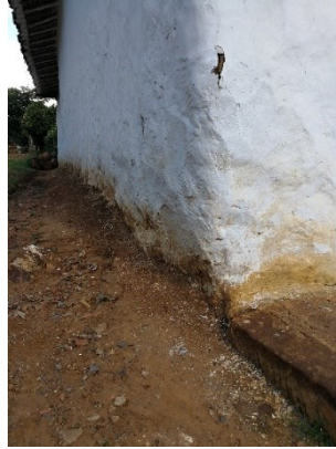
Figura 457. Cimentación oculta con pañetes, caso 17.
