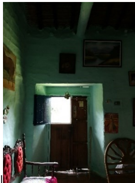
Figura 489. Puerta con jambas ochavadas, caso 12.
