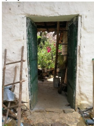
Figura 325. Entrada posterior a la galería, caso 12.
