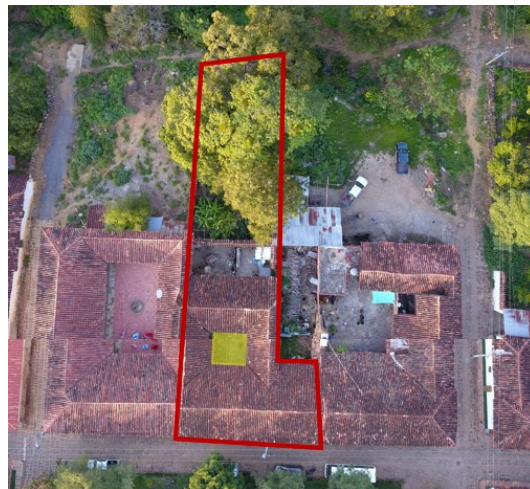
Figura 245. Construcciones de patio central sobre el parque principal, caso 11
