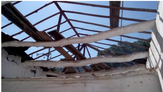
Figura 370. Obra de techador local.
