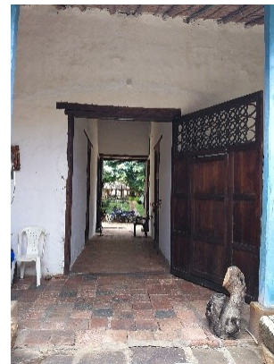
Figura 566. Portón de zaguán en madera y hierro forjado, caso 11.
