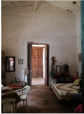
Figura 254. Piso en tablón de arcilla artesanal, caso 11.
