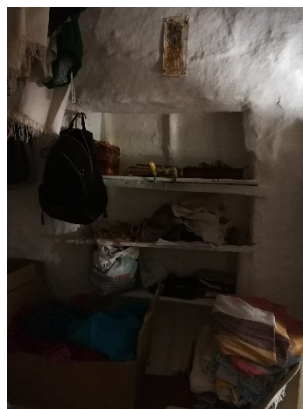
Figura 649. Repisas excavadas en el muro de bahareque, caso 17.
