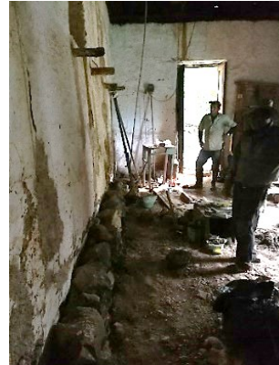
Figura 137. Jornaleros y ayudantes de albañilería reparando muros de tapia pisada, caso 20.
