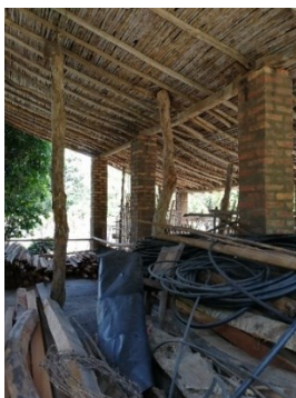
Figura 437. Columnas de ladrillo tolete, caso 5.
