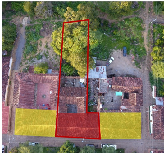
Figura 152. Edificación adosada y paramentada sobre la vía con construcciones vecinas.
