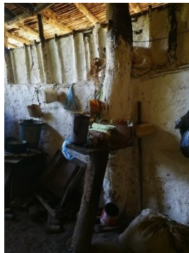
Figura 620. Vista interior de muro bahareque embutido y embarrado. caso 17.
