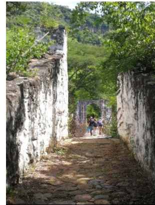
Figura 99. Puente Sardinas sobre el río Suárez que comunica Cabrera con Galán.
