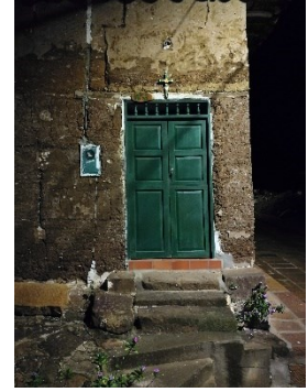
Figura 564. Puerta de bisagra a cuadros y travesaño superior ventilado, caso 14.
