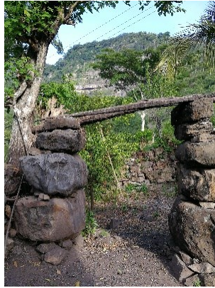
Figura 664. Travesaño en cercado de piedra.
