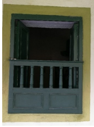
Figura 575. Barandal con bolillos torneados, caso 4.
