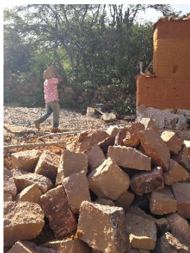
Figura 581. Trazado y construcción de cimientos. Guane.
