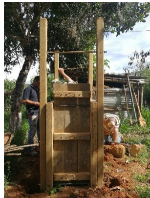
Figura 586. Encofrado de primeras hiladas. Barichara.
