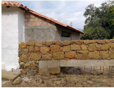
Figura 358. Cercado en piedra sobre cimiento en concreto construido en Cabrera, 2017.
