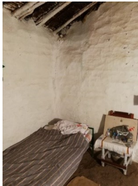
Figura 751. Dormitorio de una casa de bahareque.
