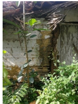
Figura 621. Vista exterior de muro de bahareque embarrado, caso 13.
