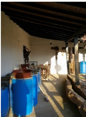
Figura 66. Galería orientada hacia el suroccidente.
