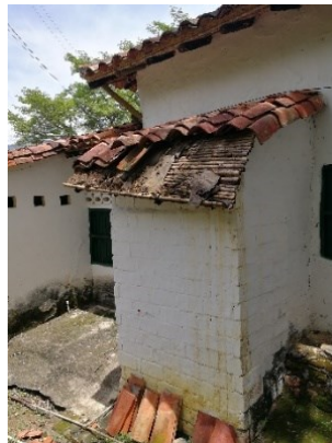
Figura 139. Baño adosado a construcción en tapia pisada, caso 7.
