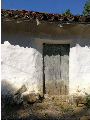
Figura 723. Lesiones sobre puerta de madera natural.
