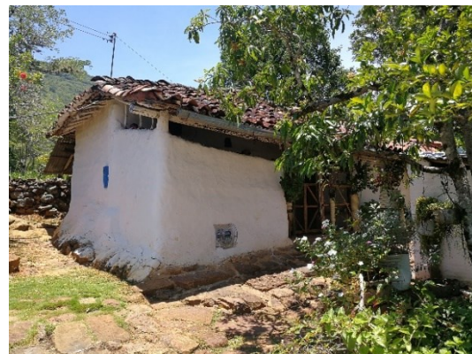
Figura 56. Edificio de bahareque embutido.
