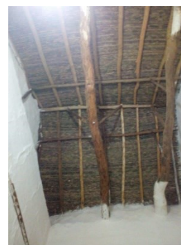
Figura 599. Nuevo tendido de cañabrava.
