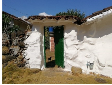
Figura 115. Cerramiento en piedra y acceso a solar, caso 18.
