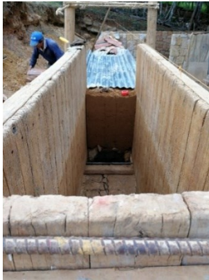
Figura 450. Tapial de madera, Barichara.
