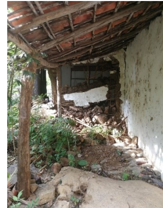
Figura 174. Galería semi abierta, caso 13.
