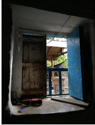
Figura 574. Ventana de dos hojas con tranca interna, caso 2.
