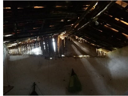
Figura 629. Hastial con cañas verticales, caso 10.
