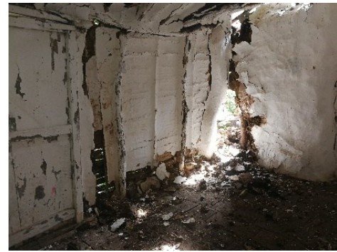
Figura 622. Vista interior de muro de bahareque embarrado. caso 13.
