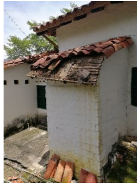
Figura 310. Baño adosado al edificio, caso 7.
