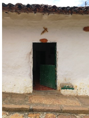
Figura 6224 Apariencia exterior del bahareque embutido, caso 15.
