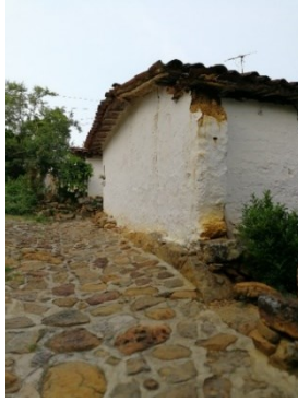
Figura 7. Construcción en tapia en el casco urbano de Guane.
