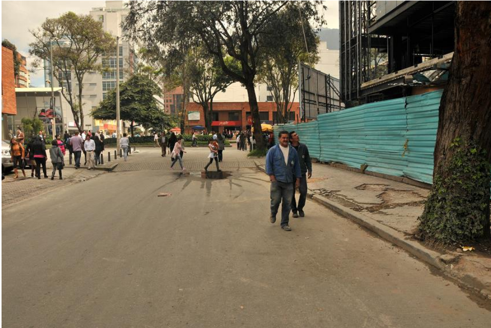
Fotografía 8-1: Estados de la vía Calle 98 entre Carreras 11 y 11a.
