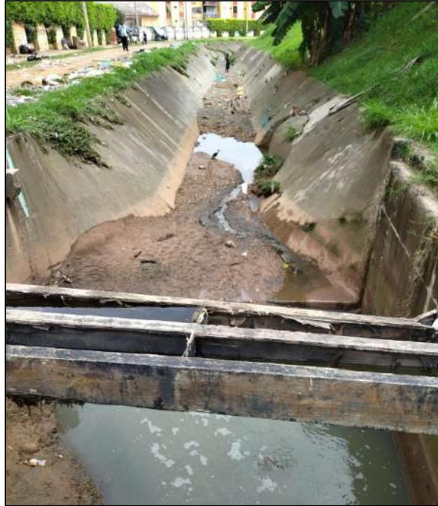
**Figura 44.** Desarenador Nápoles, excedentes de material sobre el canal.
