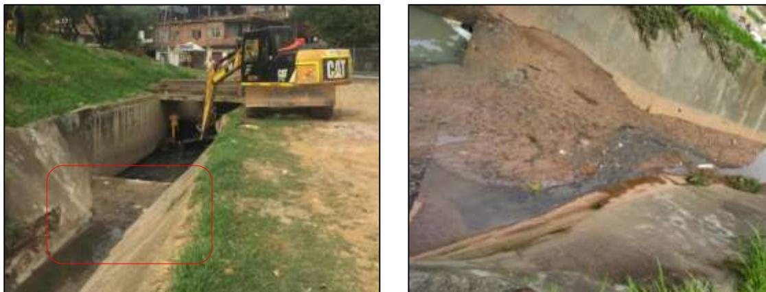
**Figura 41.** Estructura del desarenador Nápoles y material excedente sobre el canal.
