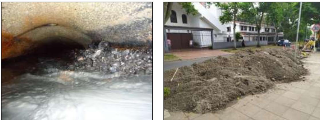
**Figura 3.** Colmatación de tramo de red de alcantarillado y mantenimientos sobre el sistema de drenaje Fuente: EMCALI (2019)
