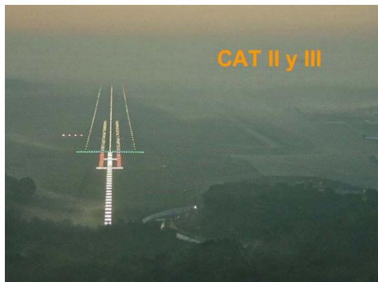
Figura 35. Iluminación Pista de aterrizaje CAT II y CAT III. - Tomado de: OACI (Chacin, 2016)
