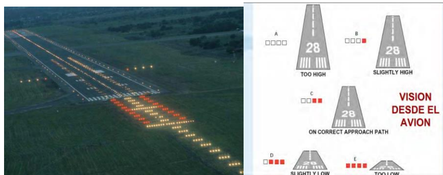
Figura 38. Iluminación en la pista de aterrizaje. - Tomado de: organización de aviación civil internacional (Chacin, 2016)
