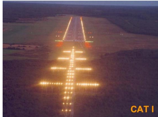
Figura 34. Iluminación Pista de aterrizaje CAT I. - Tomado de: OACI (Chacin, 2016)
