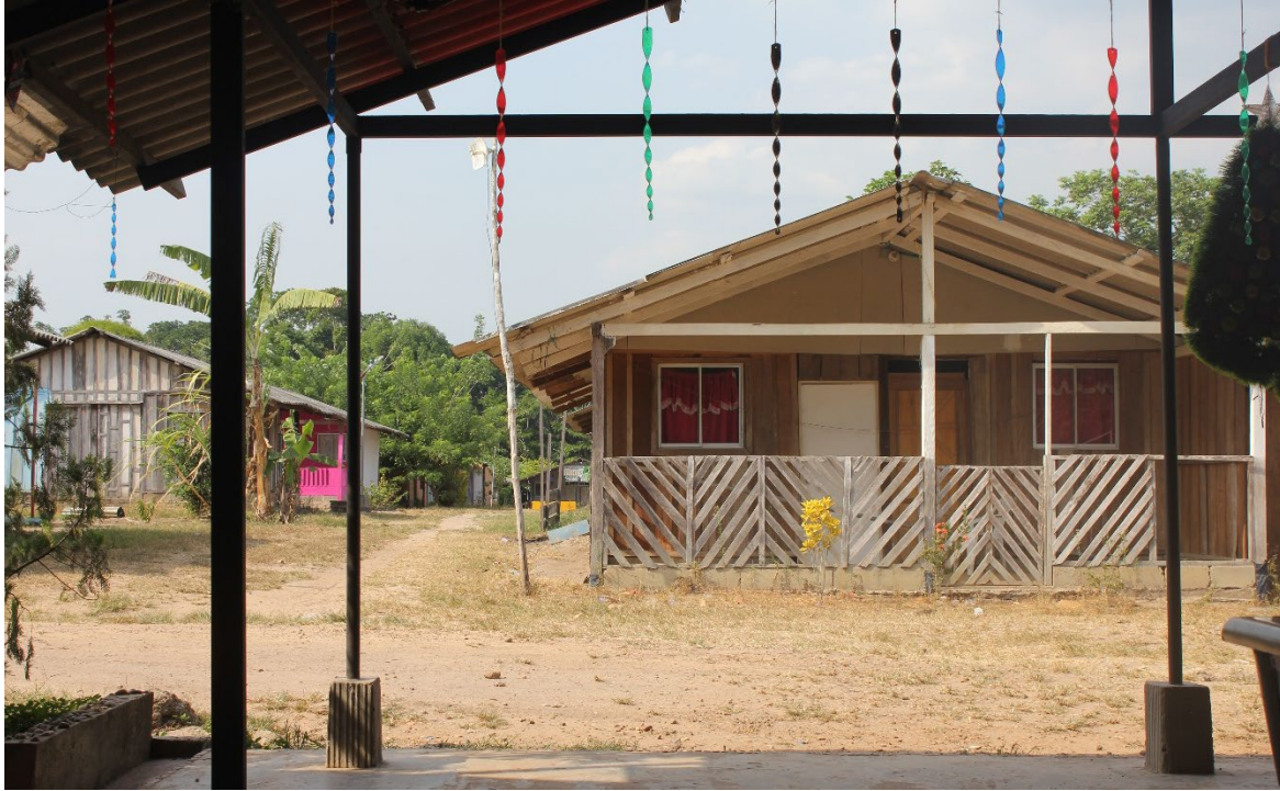
Ilustración 44: Vivienda tipo AETCR Colinas. Fuente, autor basado en trabajo de campo 2022.
