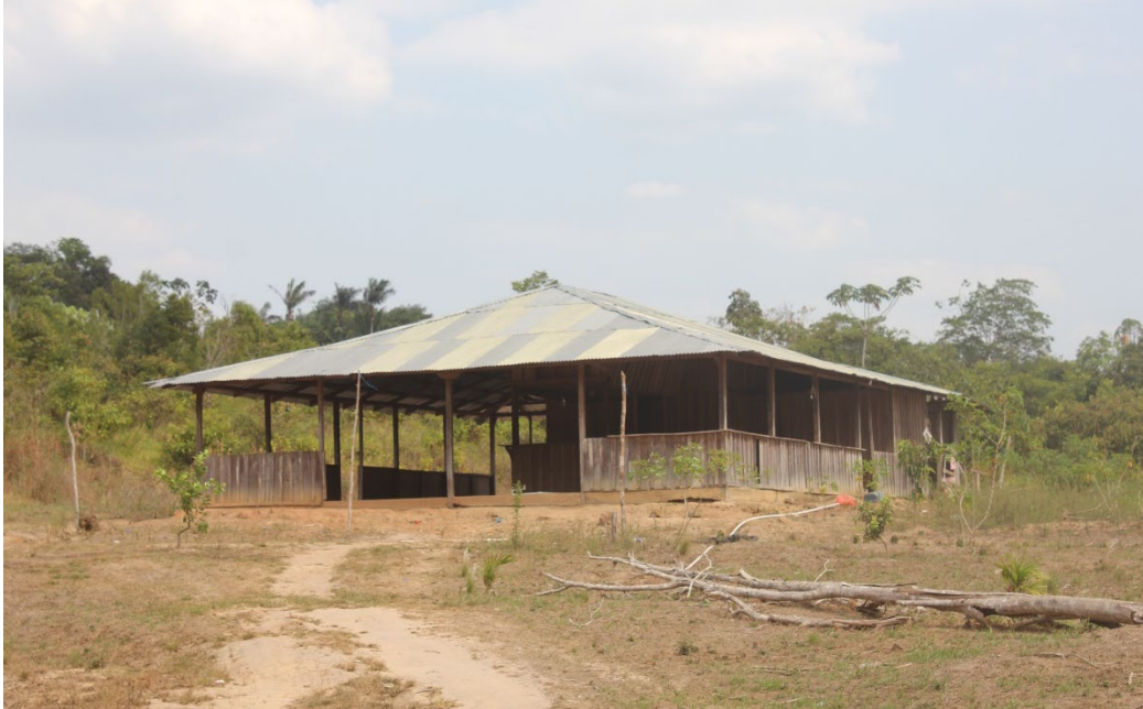
Ilustración 37: Equipamiento construido inicialmente como punto de reuniones y encuentros, hoy utilizado para el material de pozos cachameros y marraneras. Fuente: Autor, basado en trabajo de campo 2022.
