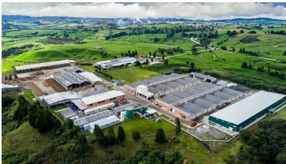
Figura 1-4: Fotografía aérea de la planta Setas de Cuivá.
