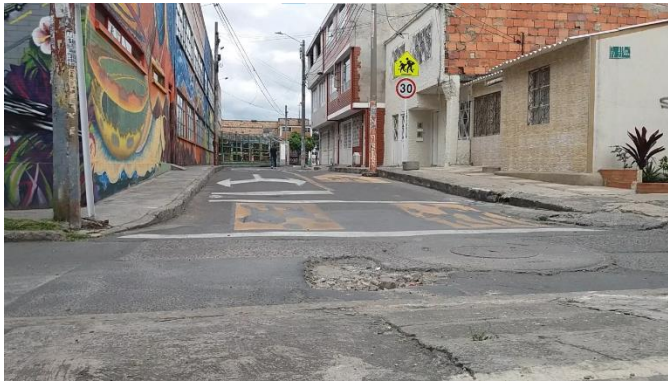
Figura 2-7. Calle hacia la casa del RCC (2021)
