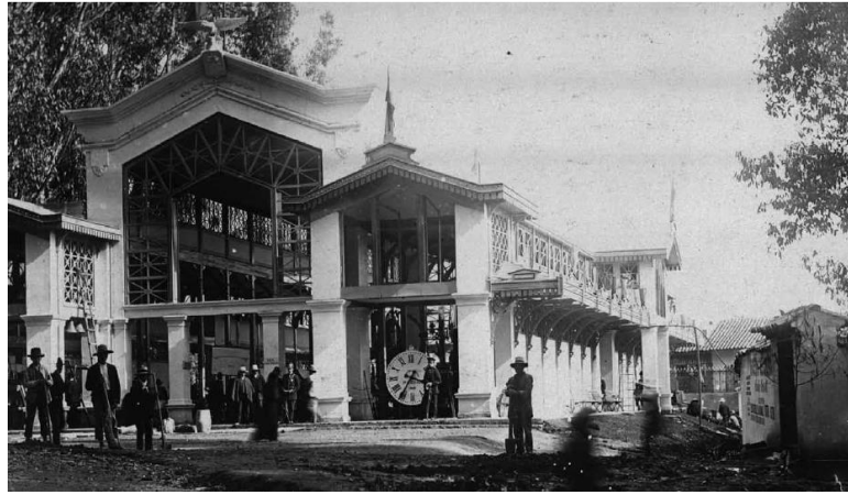
Figura 1-2. Pabellón de Maquinaria en el parque de la Independencia en Bogotá
