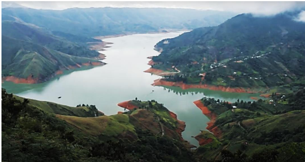
Figura 3-160: Vista de la represa de la Salvajina desde la parte alta de la vía de Morales a Suárez, en la parte derecha de la imagen se observa parte de la vereda Mindalá. Fotografía del autor.
