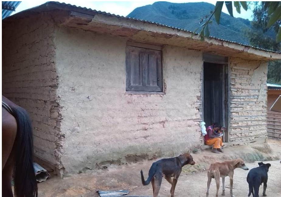
Figura 3-220: La arquitectura en tierra, bahareque con lata guadua, es una constante en el territorio de Mindalá. Fotografía del autor.
