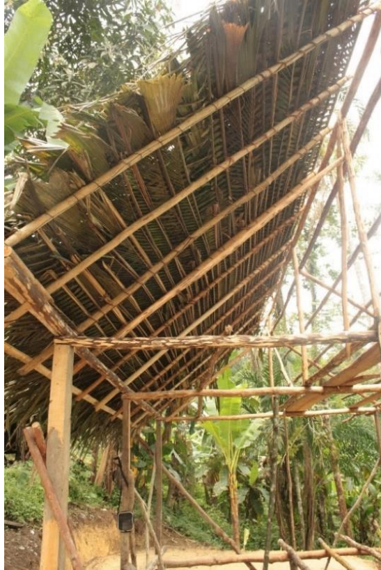
Figura 0-4: Construcción de casa en madera rolliza, cubierta en hoja de palma y amarres con bejuco, vereda Pastico rio Naya entre los departamentos del Cauca y Valle. Fotografía del autor.
