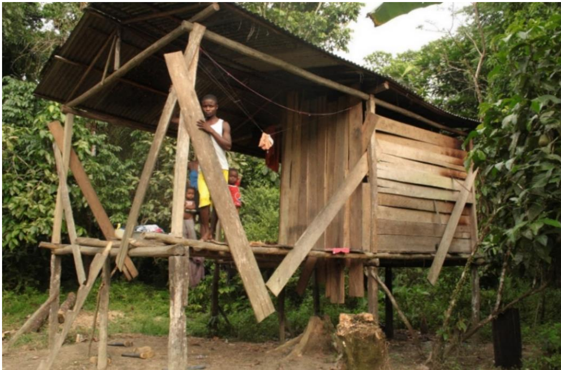
Figura 1-25: Casa de familia afrodescendiente en construcción, cuenca baja río Naya (Valle). Fotografía del autor.
