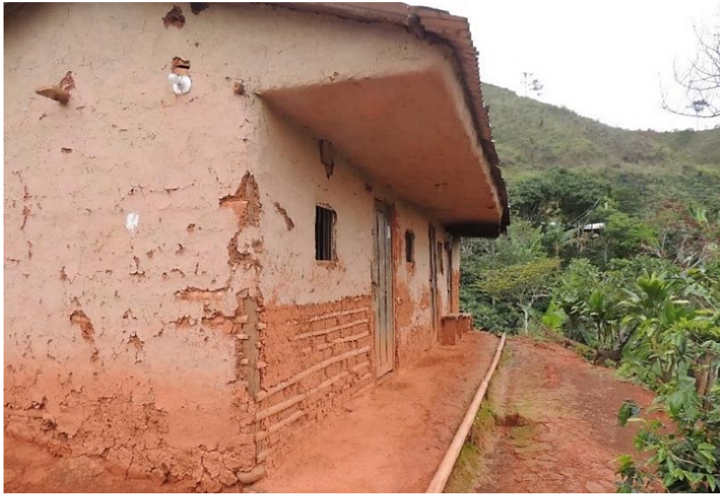
Figura 3-201: Casa en bahareque y techo en lámina de zinc. Mindalá. Fotografía del autor.
