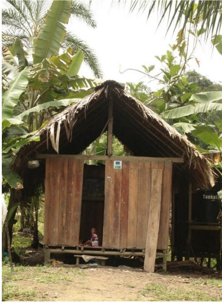
Figura 1-43: Niña sentada en el umbral de su casa en madera, construcción elevada del piso y con cubierta en hoja de palma, vereda Puerto Saija, Timbiquí (Cauca). Fotografía del autor.
