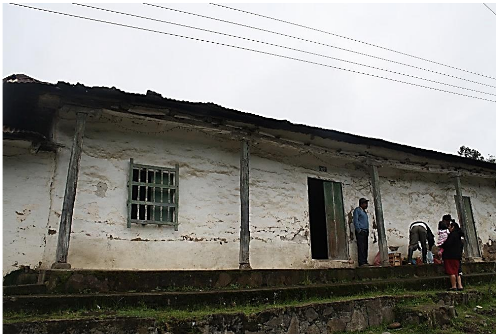
Figura 0-3: Casa en tapia pisada en el municipio de Puracé (Cauca). Fotografía del autor.
