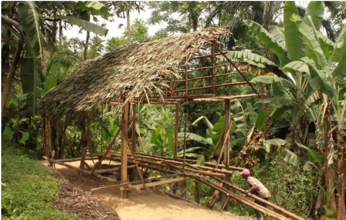
Figura 1-45: Casa unifamiliar en proceso de autoconstrucción, vereda Pastico rio Naya (Cauca y Valle). Fotografía del autor.
