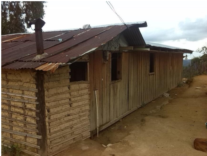
Figura 3-221: La materialización de la casa esta amarrada a las realidades de existencia y a la tradición que recoge cada familia dese la oralidad o las prácticas y técnicas aprendidas y aprehendidas, la casa se dinamiza con la complementariedad de ellas. Tierra, lata de guadua y tabla, cubierta en teja de zinc. Fotografía del autor.
