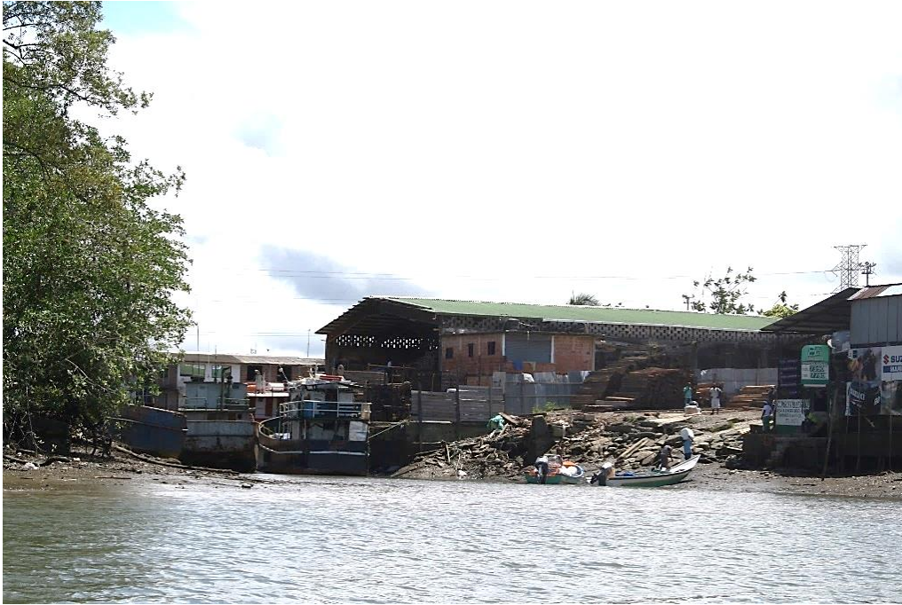
Figura 3-179: Gran parte de la zona portuaria está afectado por derrames de combustible de las naves, basuras, asentamientos informales y las intervenciones industriales propias de las actividades de un puerto. Detalle bahía de Buenaventura (Valle). Fotografía del autor.
