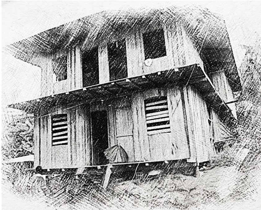
Figura 2-78: Casa construida en dos etapas, el primer piso se habita de manera transitoria y se termina posteriormente el segundo piso, se reutiliza la cubierta. Vereda Pastico (Puerto Merizalde). Fotografía editada del autor.
