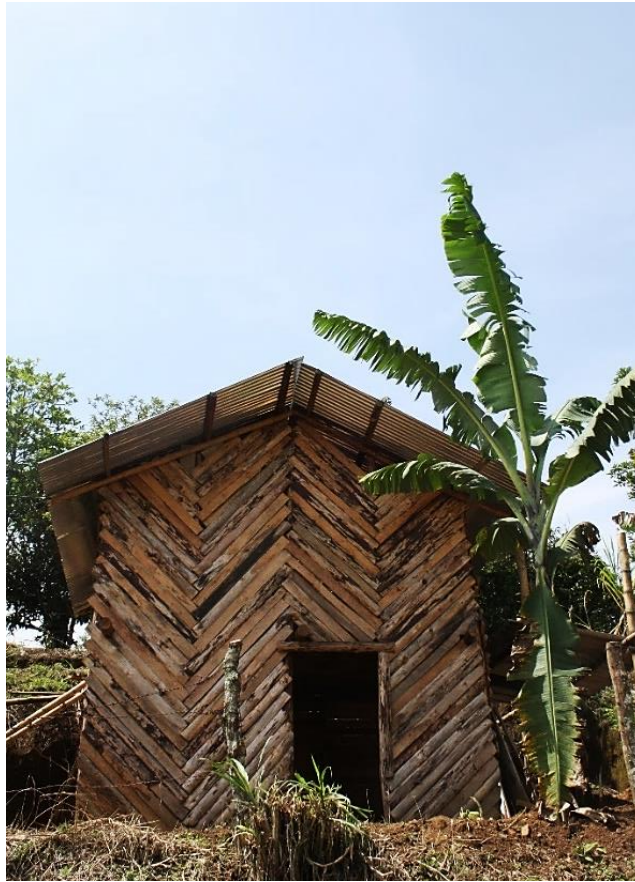
Figura 2-97: Casa en orillo de madera con piezas dispuestas de manera geométrica retomando formas de tejidos tradicionales. Fotografía del autor.
