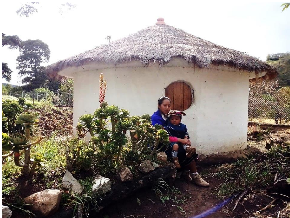
Figura 0-21: Representación casa tradicional Misak de planta circular, muros en tierra y cubierta en “paja de loma” en la casa Payan, Guambia, Silvia (Cauca) 21 . Fotografía del autor.
