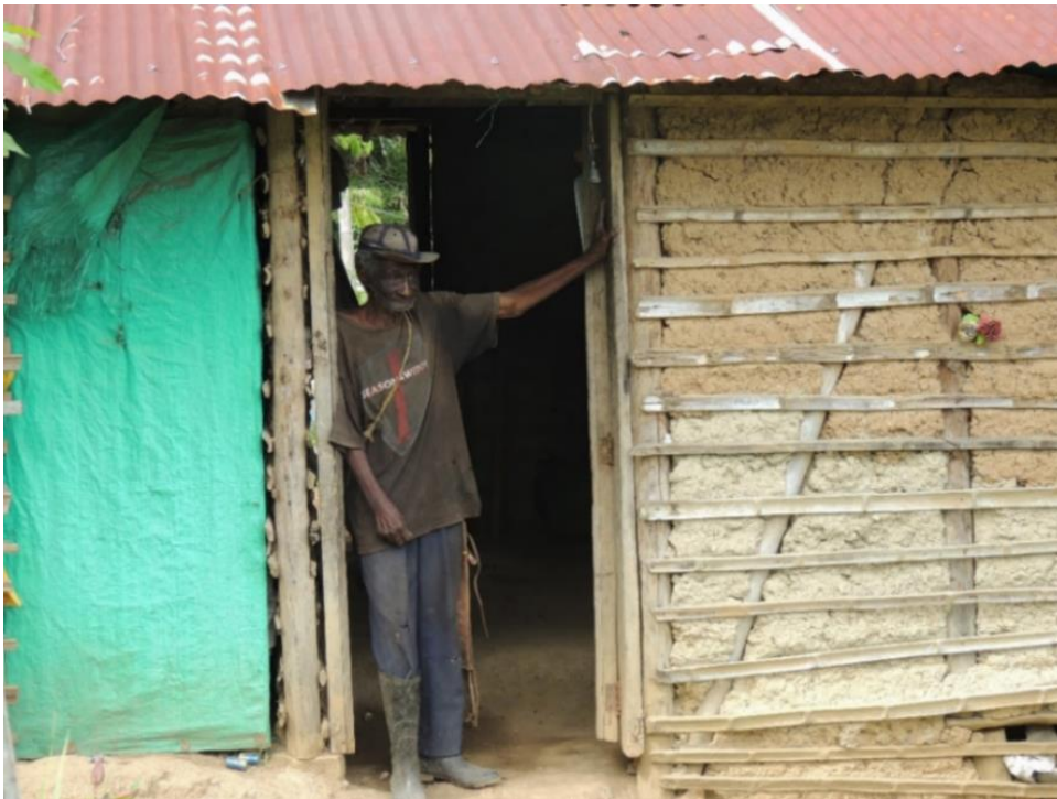
Figura 1-46: Adulto mayor afrodescendiente que habita casa con estructura en madera rolliza, muro de tierra embutida con lata de guadua y cerramiento alternativo en “yute”, cubierta en lámina de zinc y piso en tierra, vereda Mindalá, Suárez (Cauca). Fotografía del autor.
