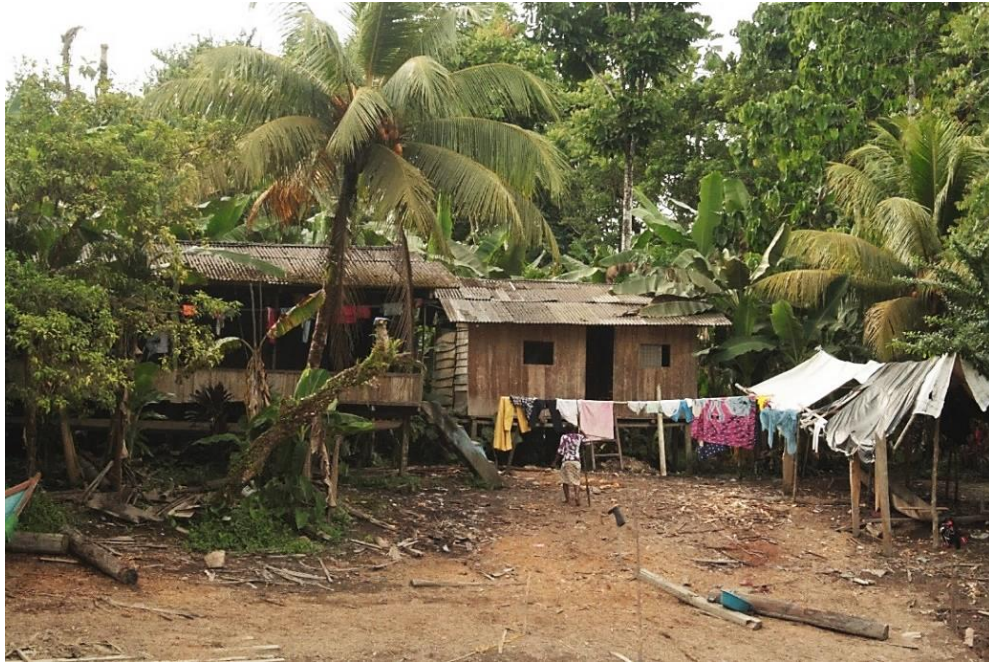
Figura 0-8: Casas palafíticas en madera aserrada, quebrada El Limón, cuenca del río Naya (Valle del Cauca). Fotografía del autor.
