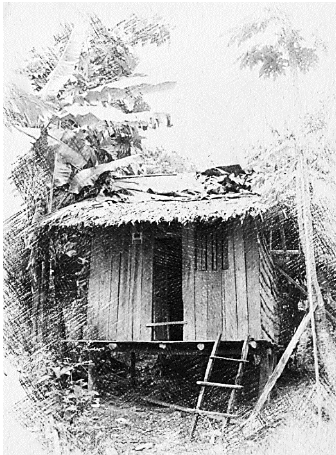
Figura 2-77: Casa palafítica básica de uno o dos espacios interiores con pequeño corredor en la parte frontal, construida en madera y hoja de palma. Vereda Puerto Saija (Timbiquí) Fotografía editada del autor.
