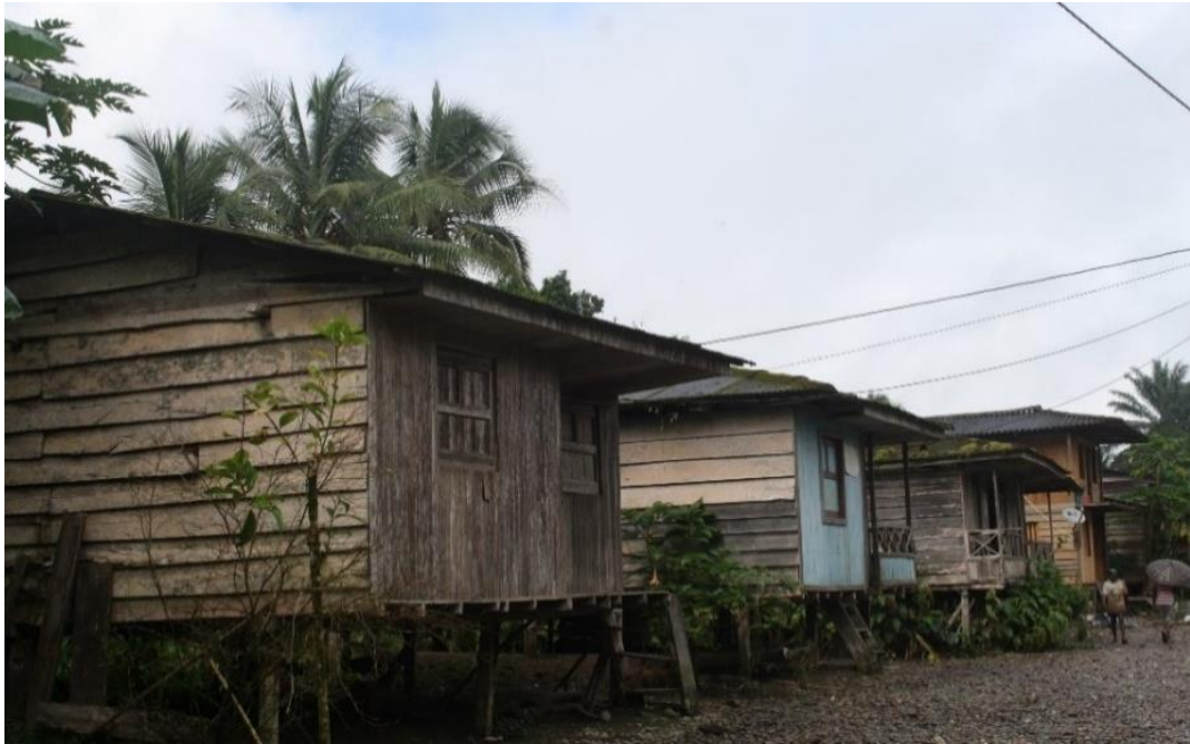
Figura 3-205: Los ritmos formales se mantienen, la casa responde a los posibles embates del río por crecientes o mareas. Fotografía del autor.
