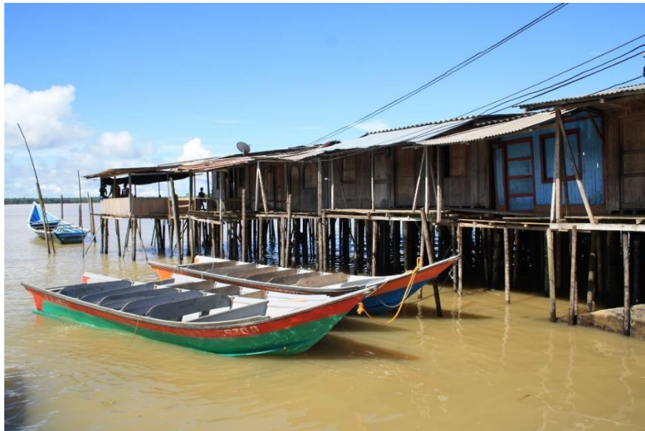
Figura 2-135: La casa sobre palafitos en estos territorios, como lugar de existencia, da la posibilidad de acercarse a la heterogeneidad del habitar. Fotografía del autor.
