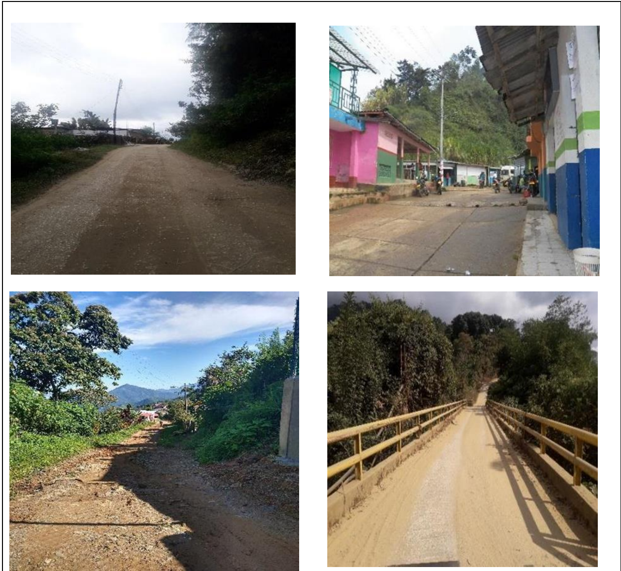
Nota. De izquierda a derecha, Aspecto de la vía de acceso al corregimiento, Placas de cemento en el centro poblado, Tramos parciales con placa Huella y Puente Kennedy. Imagen propia. 2021.
