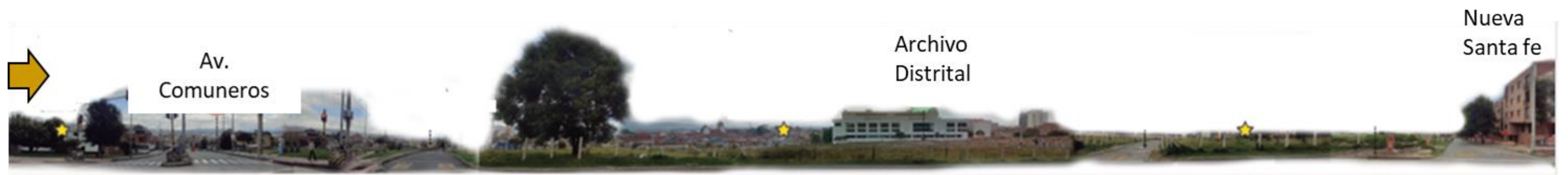
Ilustración 0-11: Continuación sur -norte Vista fachada intersección Av. Comuneros, Archivo Distrital e inicio Viviendas Nueva Santa Fe, Costado noroccidental recorrido carrera 4.
