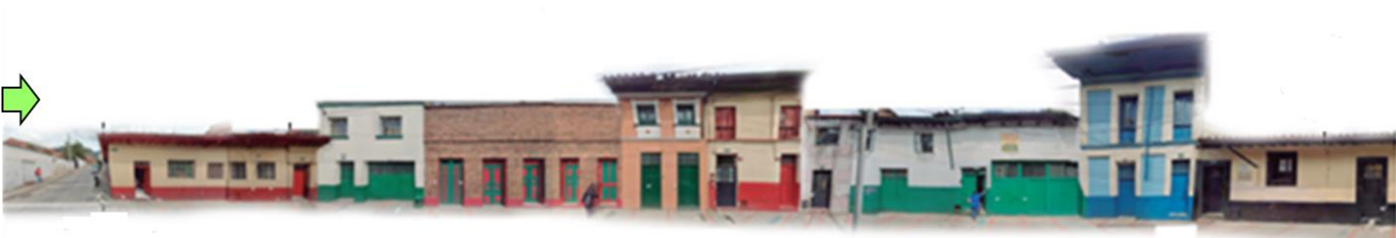
Ilustración 0-5: Inicio sentido norte – sur, Costado suroriental carrera 4
