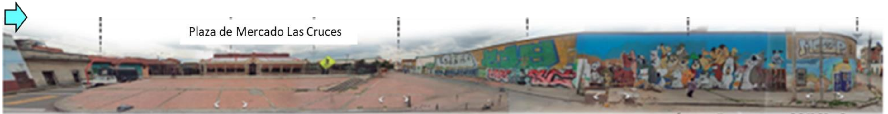
Ilustración 0-9: Vista fachada Costado suroccidental recorrido final carrera 4- Plaza de Mercado las Cruces y entorno.
