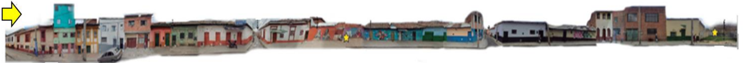
Ilustración 0-10: Continuación sur -norte Vista fachada Costado suroccidental recorrido carrera 4
