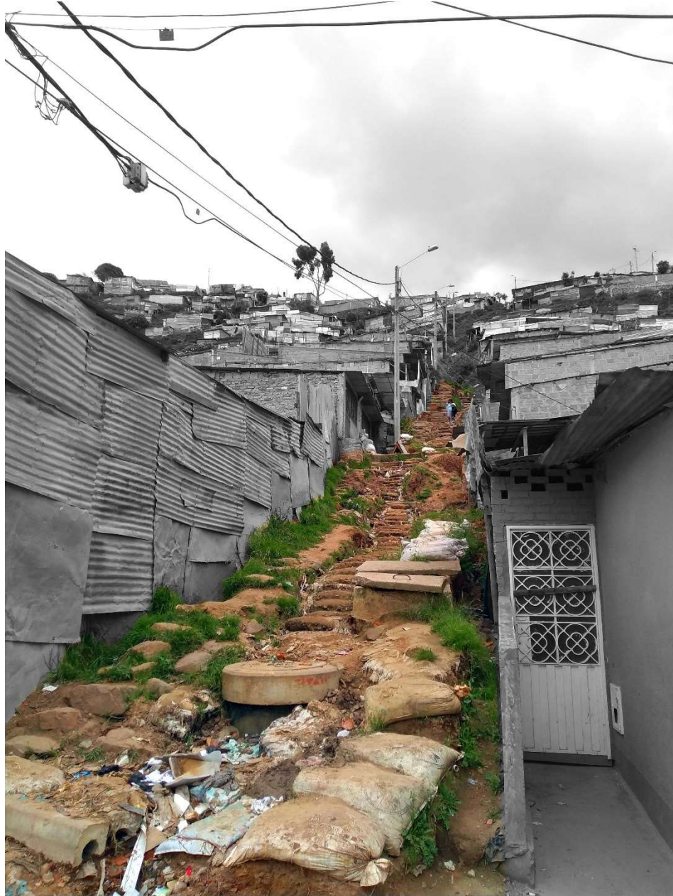
Foto 3-8: Escalones resueltos con costales rellenos con arena. (Carrera 75b con Calle 76a Sur, Caracolí). Foto tomada por Sandra Caquimbo Salazar, agosto de 2018
