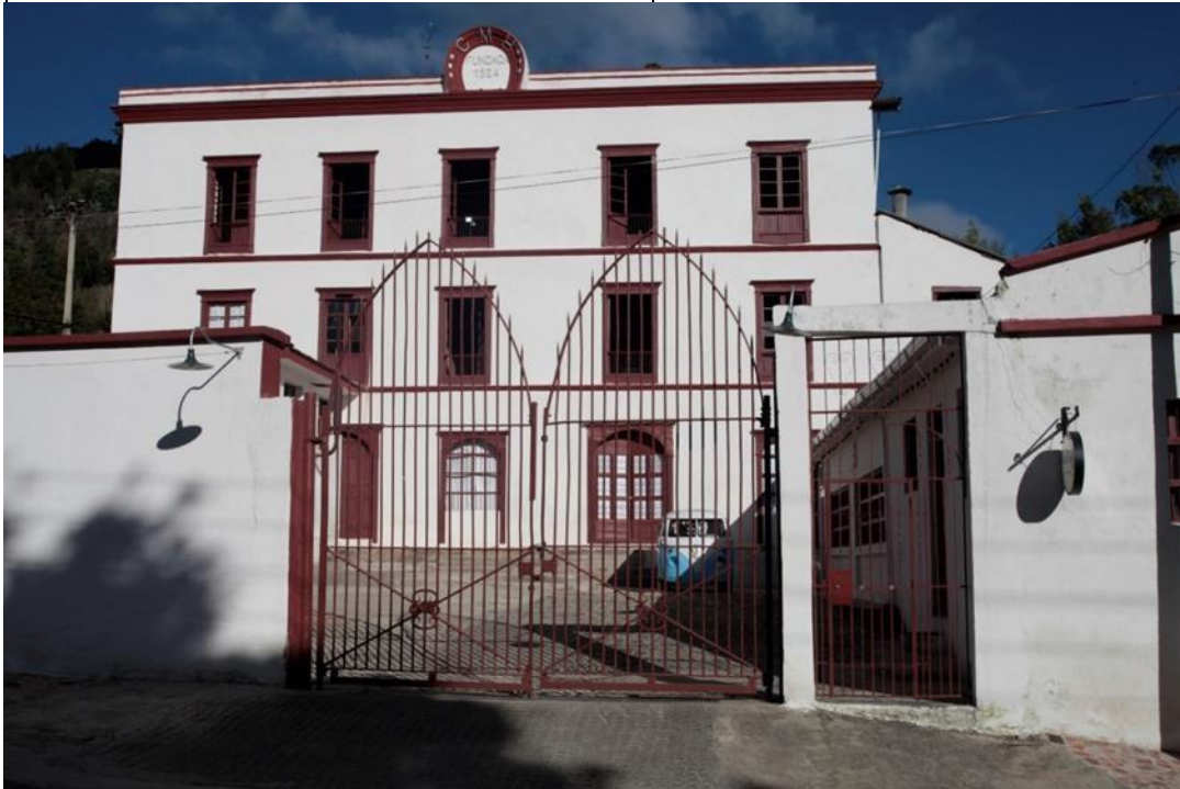
Fachada Molinera de Herrán. 2022. Fotografía Edgar Carrillo. Archivo trabajo de campo Inés Mogollón.
