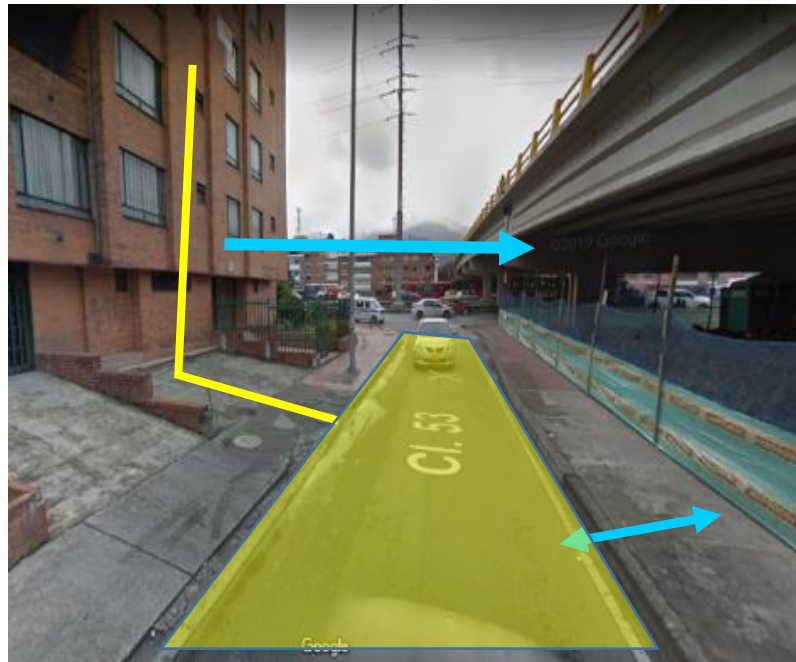
Ilustración 3-32: Culatas generadas por puentes vehiculares
