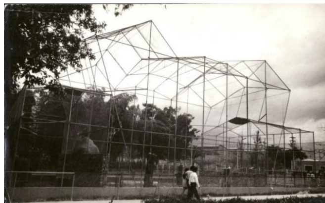
Figura 1. Construcción zoológico Santa Fe, 1960
