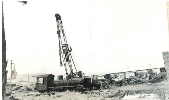
Figura 2. Construcción zoológico Santa Fe, 1960
