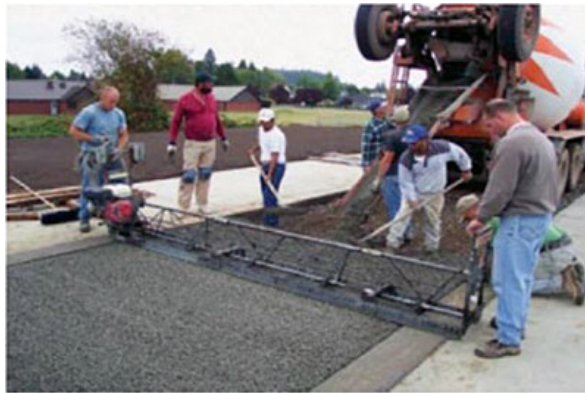
Figura 7-11: Concreto permeable en vías [43]
