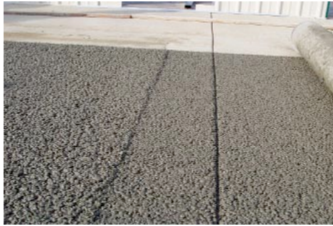
Figura 12-5 : Colocación y consolidación. [43]
