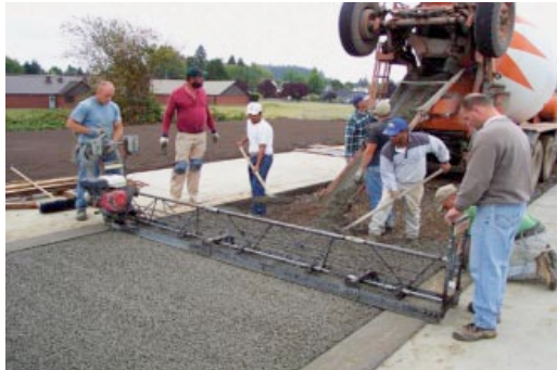
Figura 12-4 : Transporte y colocación de concreto permeable. [43]
