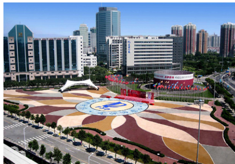
Figura 7-12: Concreto permeable decorativo para los juegos olímpicos de 2008, Beijing (China). Foto: concrete decor journal. Vol.10 no.2 feb/marzo 2010.
