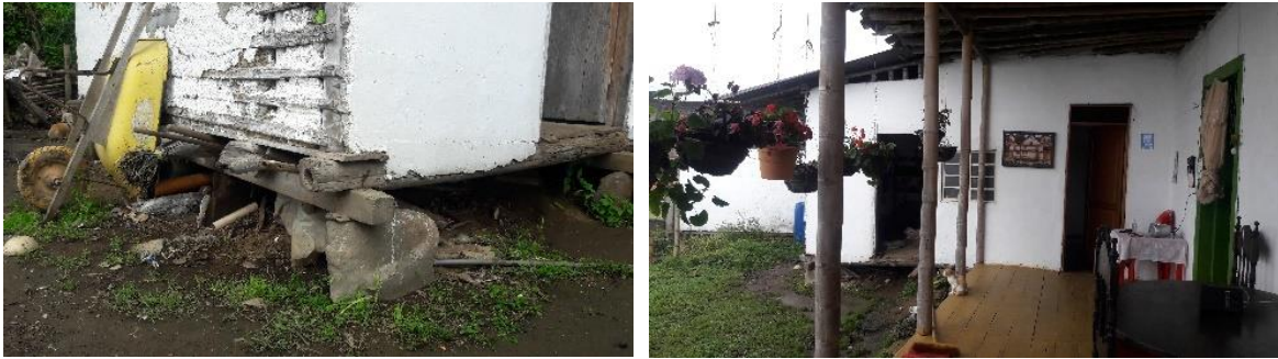
A la izquierda el cimiento aéreo de la casa tradicional. A la derecha el corredor sobre la tarima con pies derechos de guadua que sostienen la cubierta. Vereda Campoalegre, Aranzazu. Fuente: JM Sarmiento.
