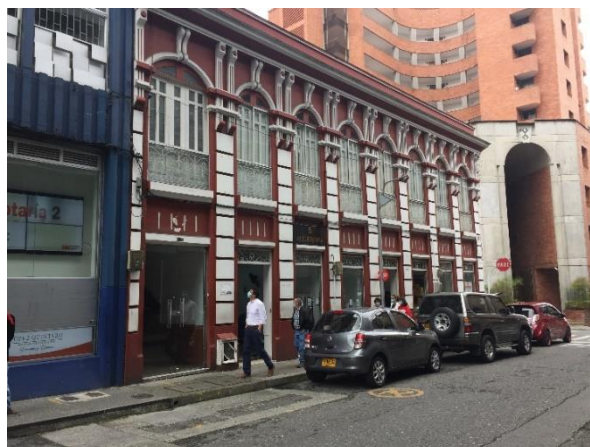
Figura 158. Fachada por la calle 22.
