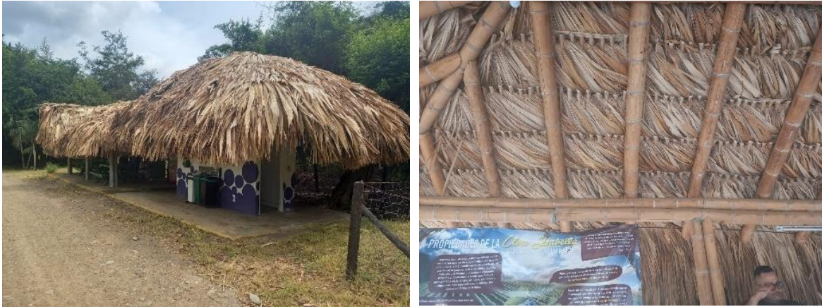
A la derecha se ve la forma de ubicar los haces de palma sobre la estructura de guadua. La Unión, Valle. Fuente: JM Sarmiento.
