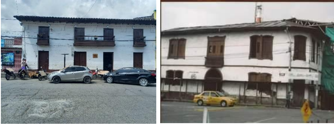
Figura 41 y Figura 42. Dos casas de tradición colonial.
