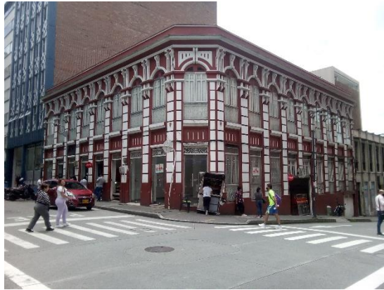
Figura 157. Fachada de la casa frente al ochave.
