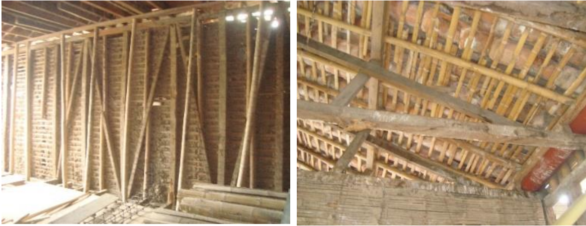
Figura 63 y Figura 64. La guadua prima en las construcciones de bahareque.
