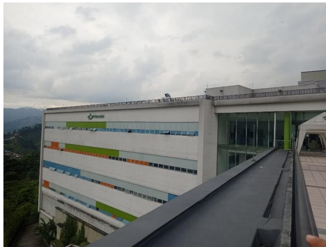
Figura 82 La Unidad Hospitalaria Nuevo Occidente
