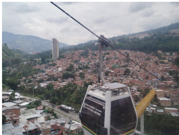
Figura 62 Cabinas del metrocable línea La línea J
