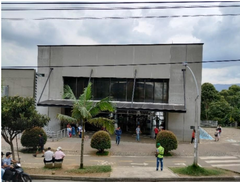
Figura 67 Edificio de la Estación de Metro La Aurora–Línea J
