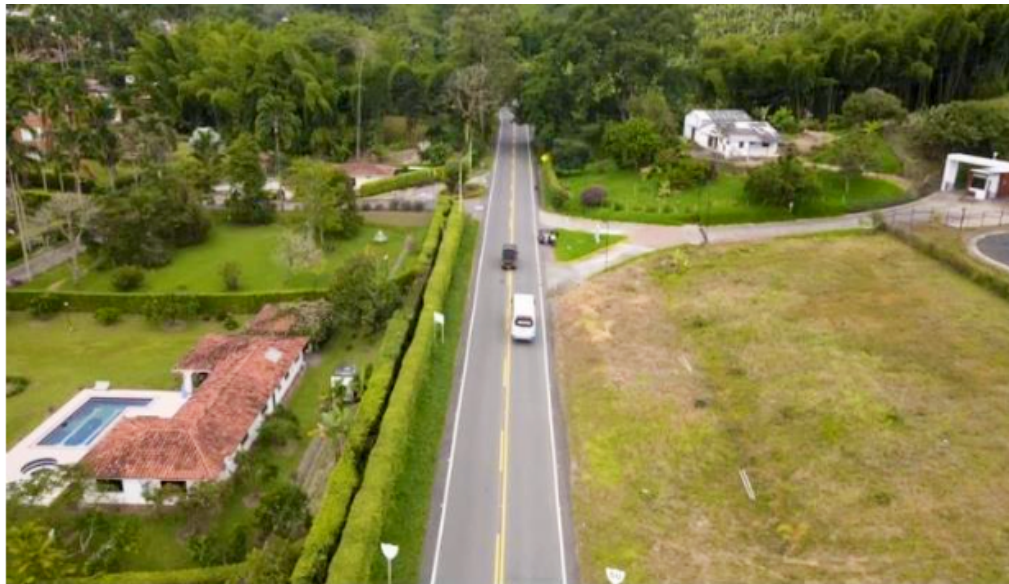
Vista frontal del lugar del AT (kilómetro 9+700 en el sector Tres Puertas, Puente la Libertad)
