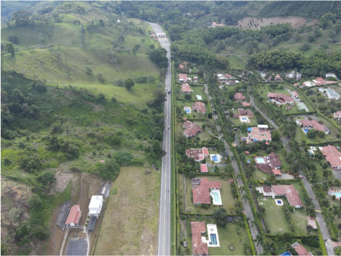
Vista general tomada desde dron tomada por Geólogo de Ejip S.A.S.
