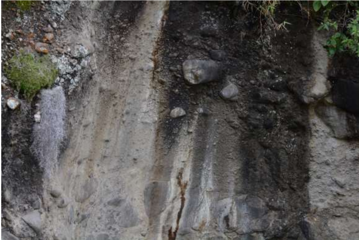
Figura 1-8: Bloques en matriz de roca BIM Rock costado derecho puente Guáitara.
