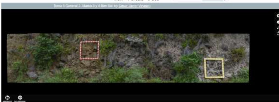
Figura 3-72: Toma cargada en Gigapan.
