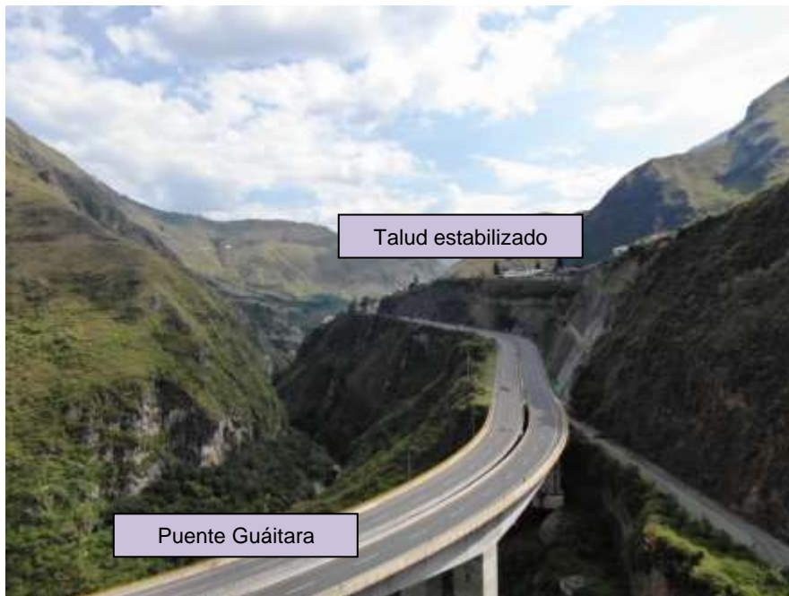
Figura 1-6: Vista aérea Puente Guáitara
