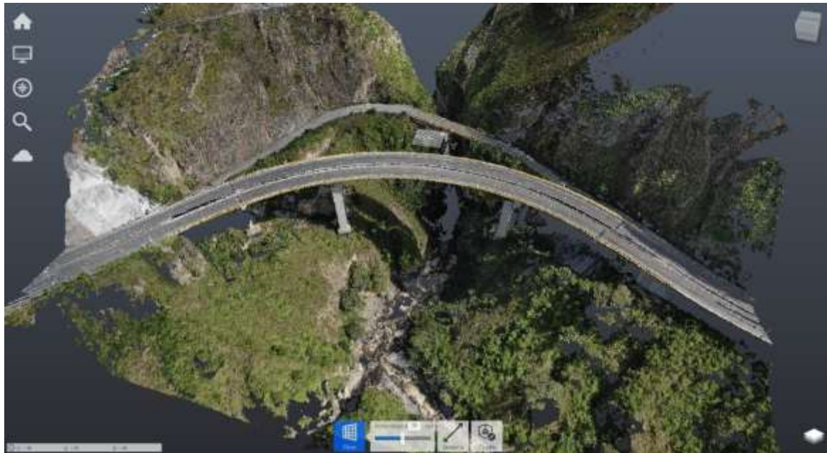
Figura 3-63: Modelo 3D generado mediante levantamiento con Dron.
