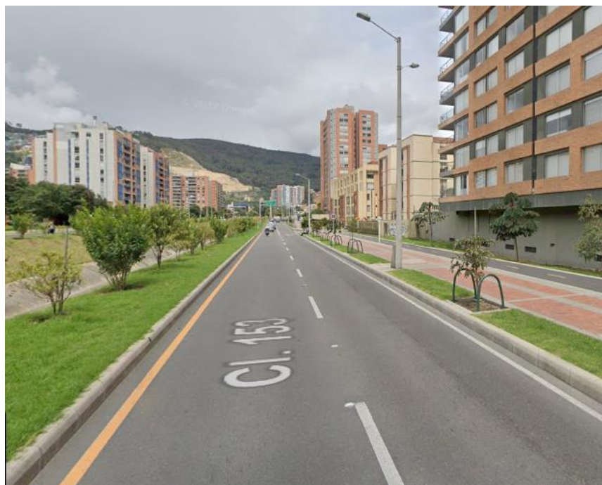
Ilustración 47. Calle 153 entre carrera 9a y carrera 7ª
