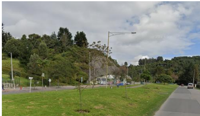
Ilustración 5. Calle 170 desde la Avenida Boyacá hasta la Avenida Cota
