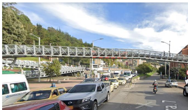
Ilustración 7. Puente peatonal ubicado en la Calle 182 con carrera 7ª
