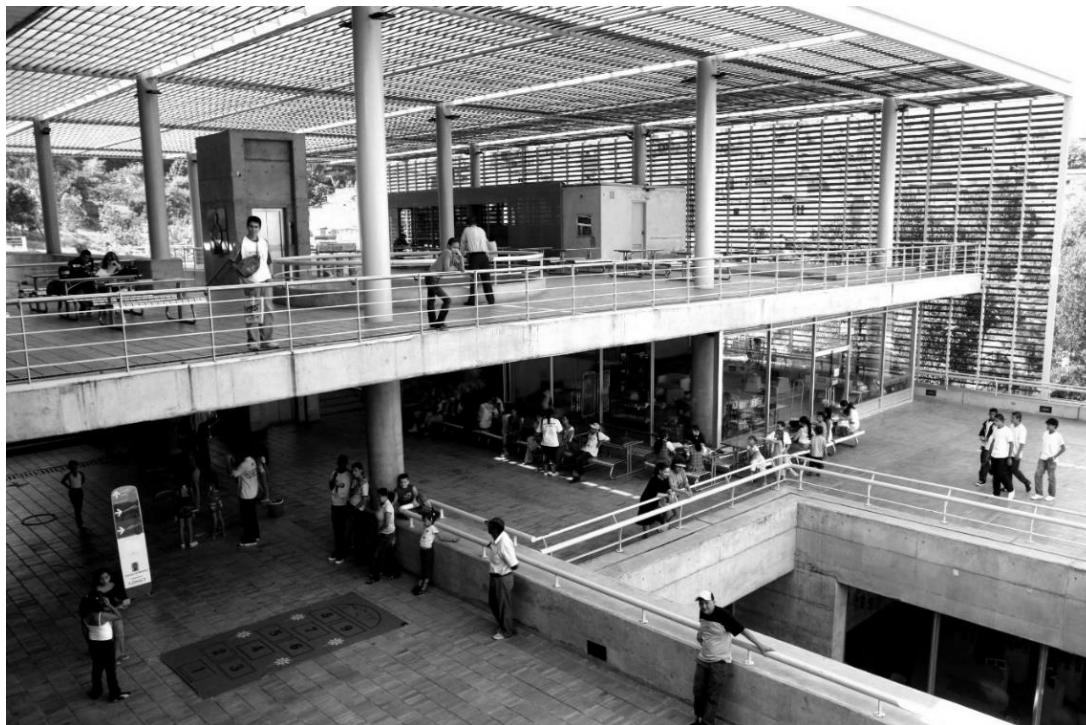
Fig. 69 Vista terrazas biblioteca Fuente: www.elcolombiano.com
