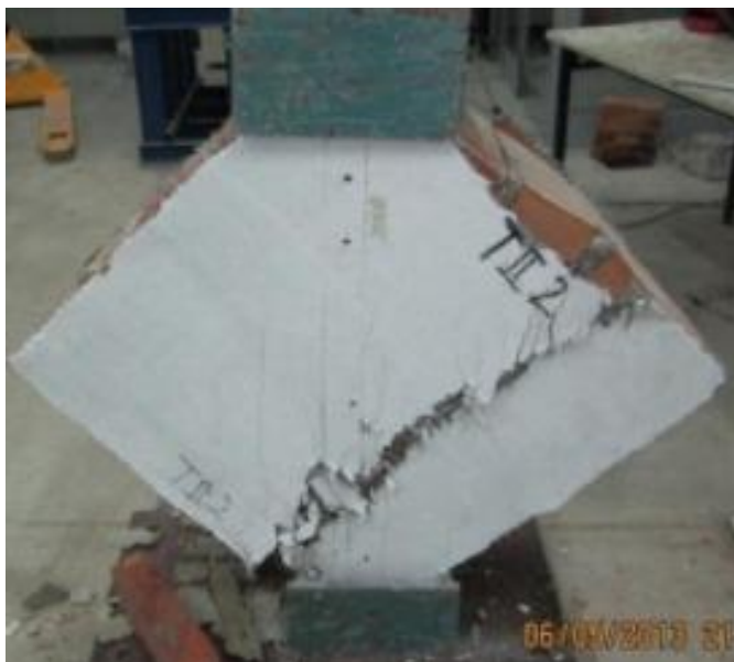
Figura 2-8. Desprendimiento del refuerzo con TRM. Fuente: (Yardim & Lalaj, 2016)
