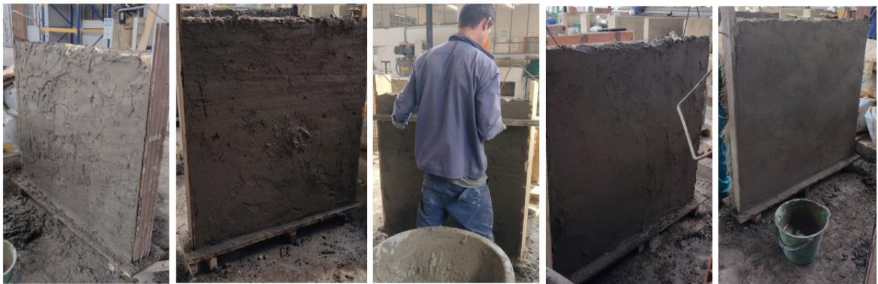
Figura 3-51. Registro fotográfico de 2da etapa de reforzamiento mediante TRM fique
