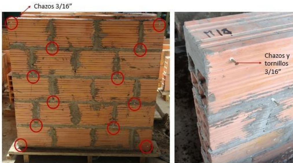
Figura 3-49. Registro fotográfico de ubicación de chazos en muros de prueba
