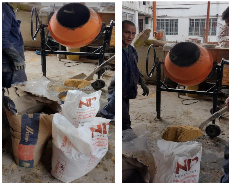
Figura 3-36. Preparación mortero de pega para construcción de muros
