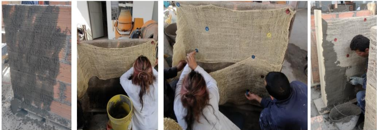
Figura 3-50. Registro fotográfico de 1ra etapa de reforzamiento mediante TRM fique
