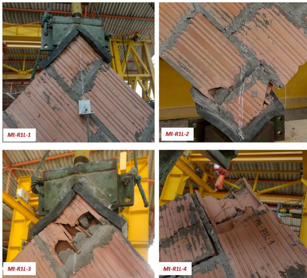
Figura 4-23. Registro fotográfico falla por aplastamiento en los apoyos Mt-R1L
