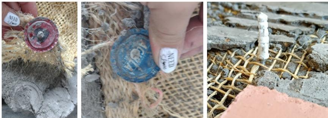
Figura 4-33.Registro fotográfico de tapas metálicas de conectores.
