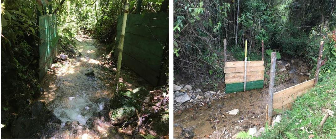
**Figura 3.13:** Vertedero abierto tipo canal mejorado, instalados en los puntos de cierre de las cuencas El Silencio, Montañita y pastos.
