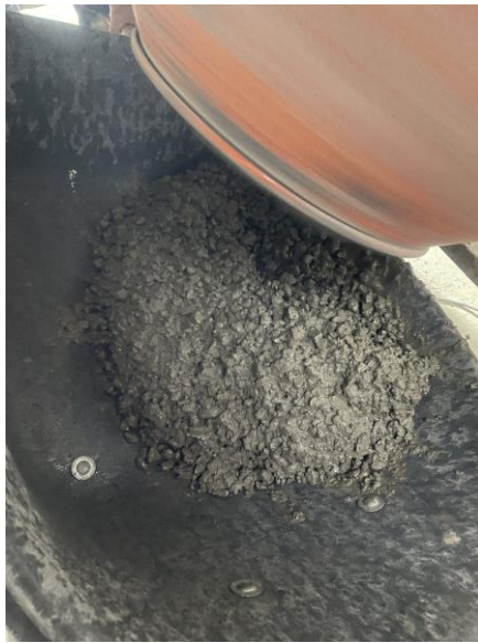
Ilustración 16 Mezcla en trompo Fuente propia
