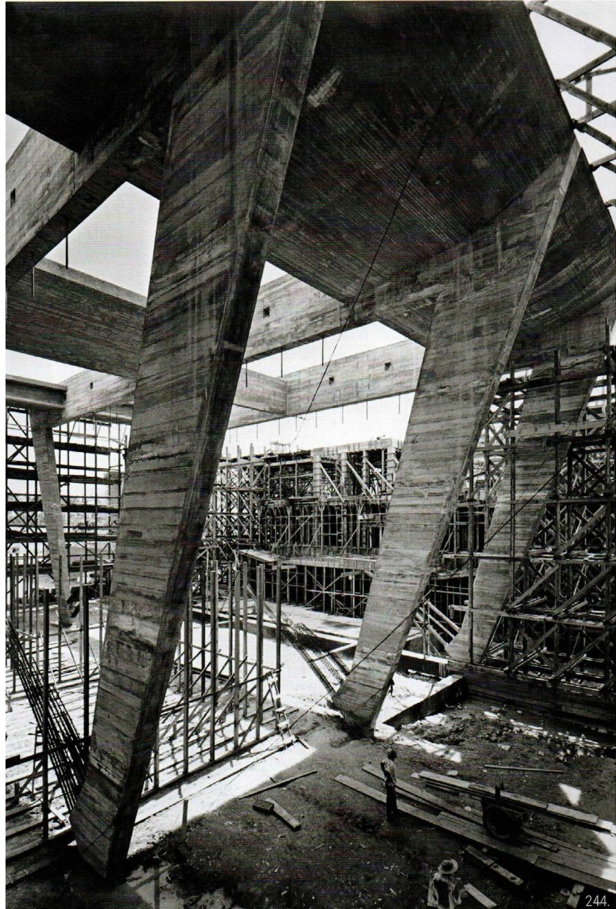
244. Detalle de la construcción del esqueleto del MAM RJ con la exposición del concreto expuesto como material primigenio.
