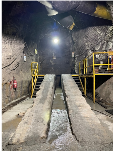
Ilustración 5-5: Taller mecanico con sostenimiento en malla, nivel 12
