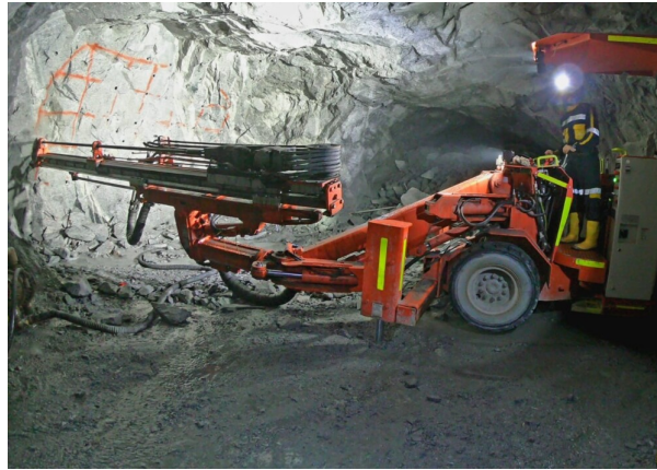
Ilustración 5-8: Operador de perforadora jumbo, antes de la labor
