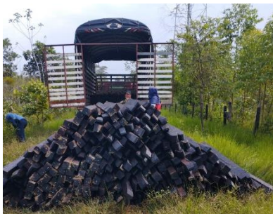
Imagen 5- 6. Descargue de postes de madera para cercado Fuente: autoría propia
