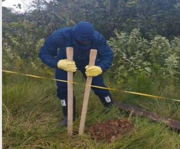
Imagen 5- 13. Ahoyado para poste de madera Fuente: autoría propia
