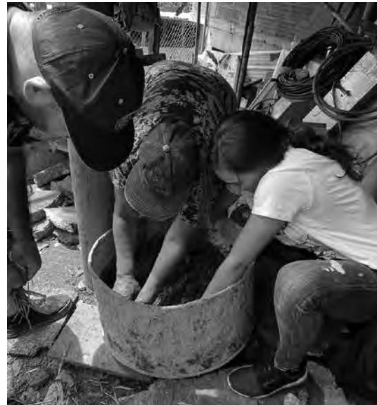
Figura 7.12 Preparación del barro Fuente: fotografía de Tabita Slimmens.
