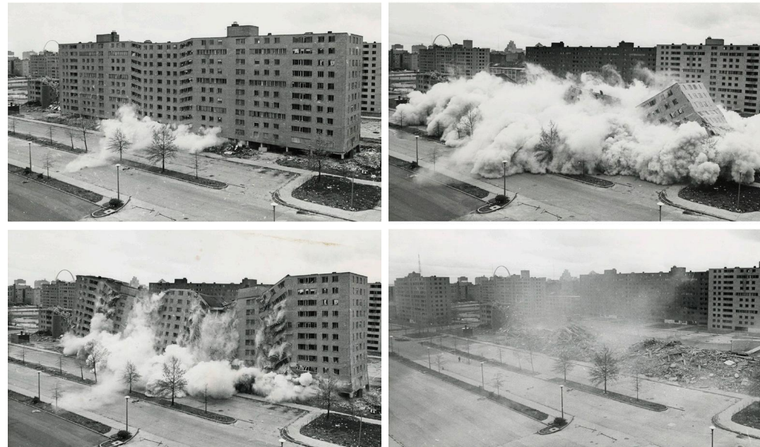
Figura 89. Secuencia de Imágenes de demolición de Pruitt-Igoe.
