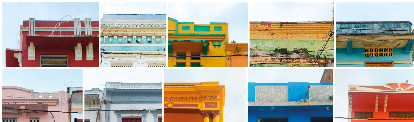
Repertorio de parapetos con molduras y cornisas de las viviendas sobre la plaza principal
