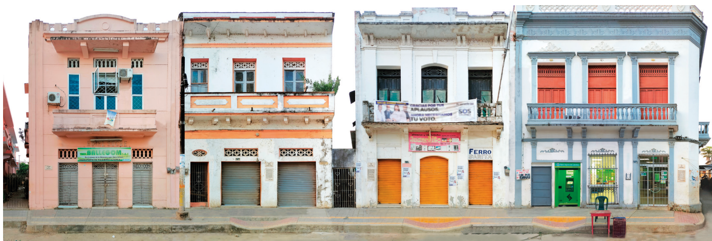
Fachada sur de la plaza principal. Continuo urbano
