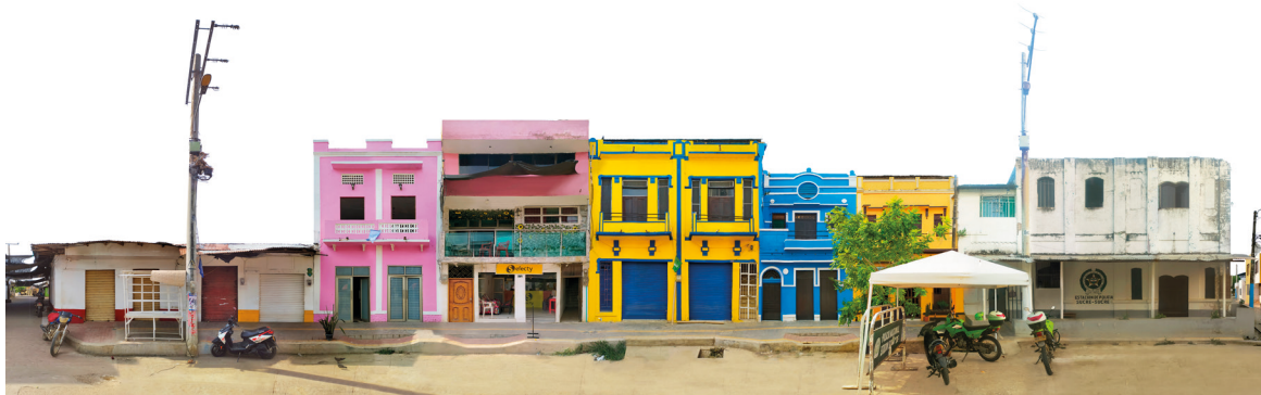
Fachadas frente al costado norte de la iglesia. Continuo urbano de la Calle 10, entre carreras 2 y 3
