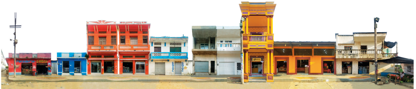
Fachada sur de la plaza principal. Continuo urbano de la Calle 9, entre Caño Mojana y carrera 1
