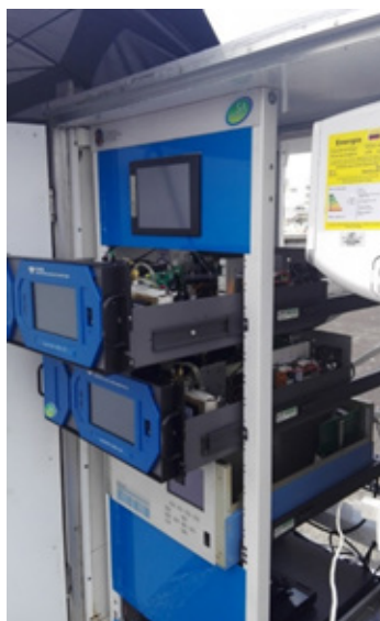
Figura 5. Cabina de gases ( \text{SO}_2 , \text{CO} y \text{O}_3 ) de la estación Gobernación Fuente: elaboración propia
