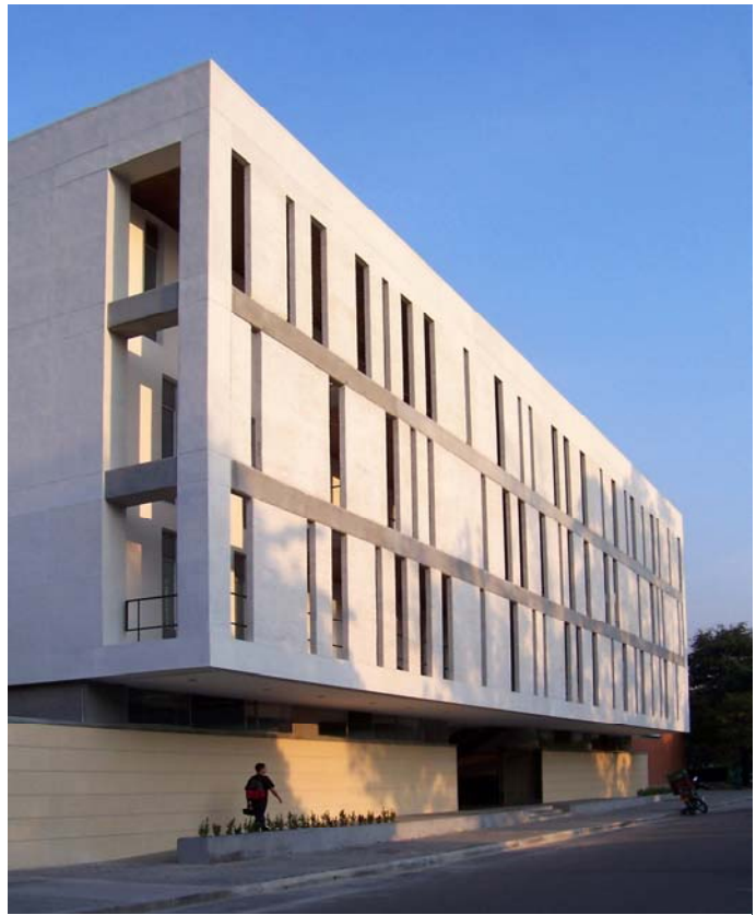
Figura 1. Fachada oriental del edificio de aulas de la Facultad de Ingenierías de la UPB en Medellín. Dieciséis aulas, cuatro por piso, que se iluminan y ventilan exclusivamente por sus fachadas oriental y occidental.
